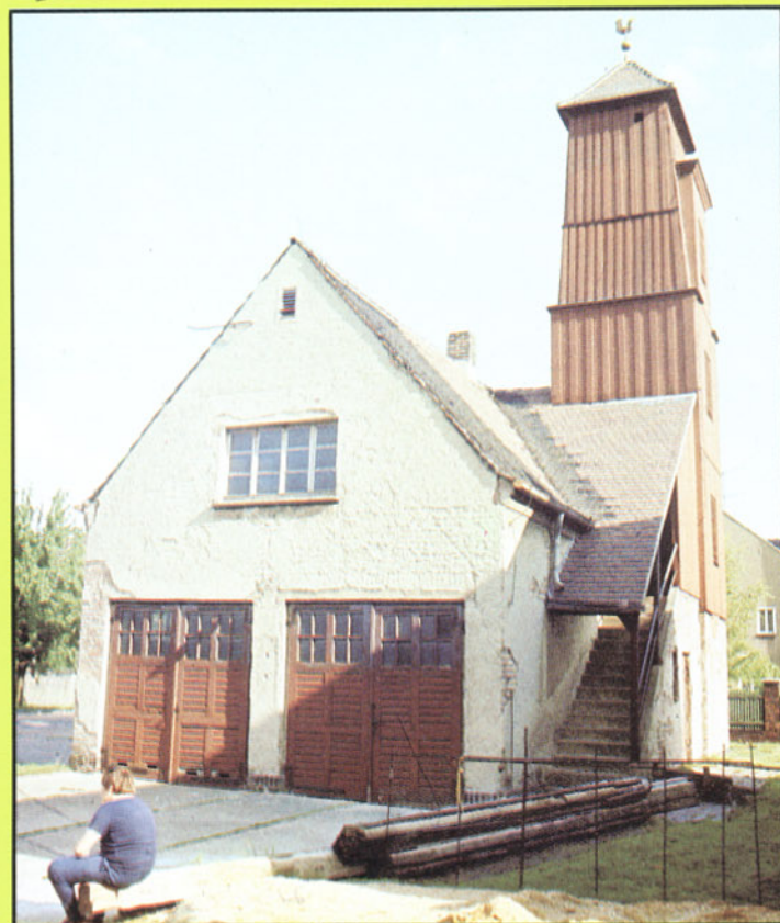
Bild 1: Vorbildlicher Nachbau des Meuchener Feuerwehrhauses mit Schlauchtrockenturm.
