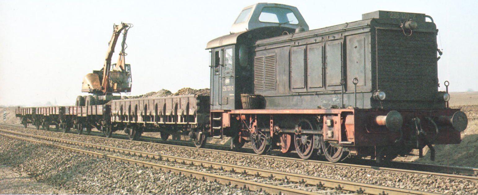
Bild 1: Die 236 120 (vormals V 36) ist am 22.3.1973 mit dem Arbeitszug auf der Strecke. Es werden Sanierungsarbeiten am Drainage-Graben vorgenommen.
