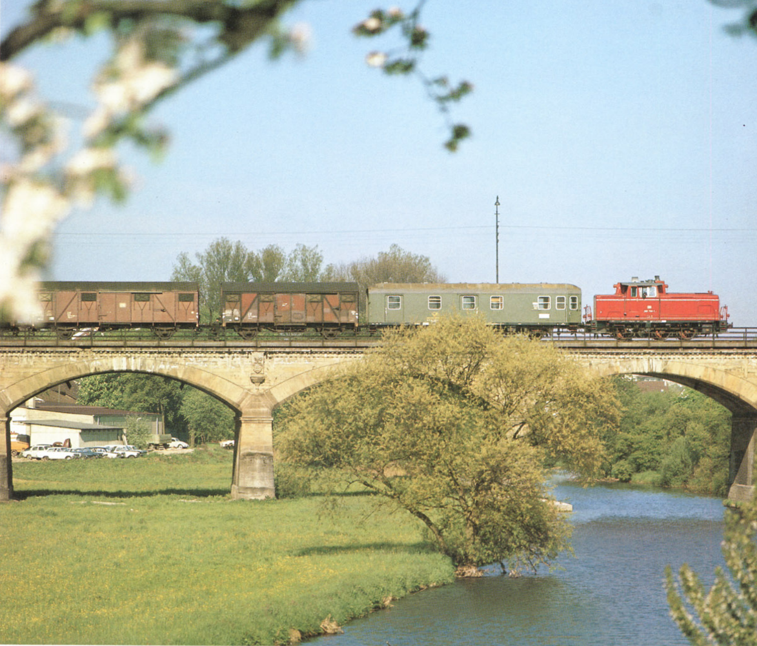
Bild 18: In Crailsheim entstand diese Aufnahme eines Nahgüterzuges im Mai des Jahres 1973. Längst hatten die Diesellokomotiven der Baureihen 260/261 die alten Dampflokomotiven im Verschiebe- und Übergabedienst abgelöst.
