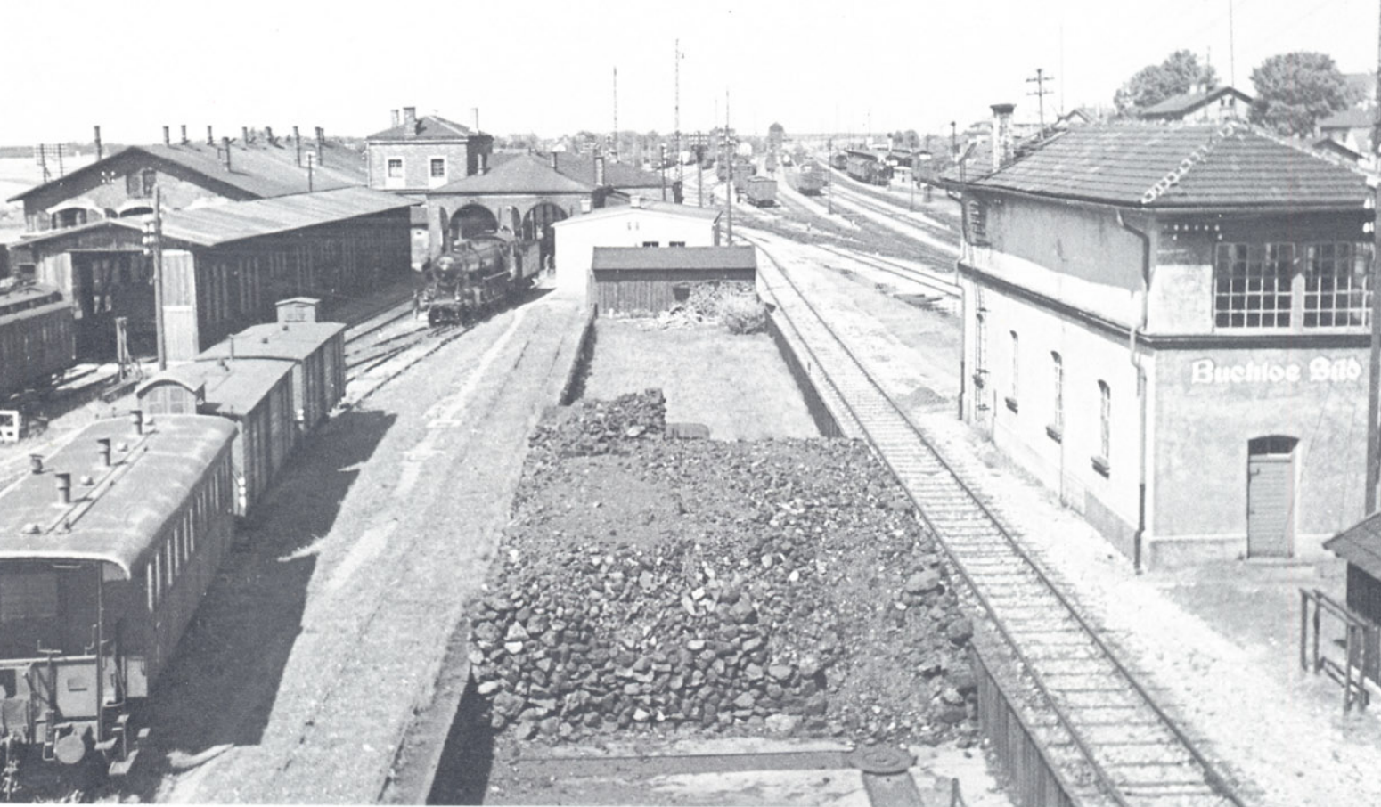
Bild 3: Das Bw Buchloe im Jahre 1937, von der Bekohlungsanlage aus gesehen: links das Haus 2, gebaut im Jahre 1879, daneben das Haus 1 aus dem Jahre 1874. In der Halle aus Holz vor Haus 1 und 2 war die Wagenausbesserung untergebracht. Die drei Wagen am linken Bildrand dienten als Hilfszug. Foto: Lichtbildstelle der Bundesbahndirektion München
