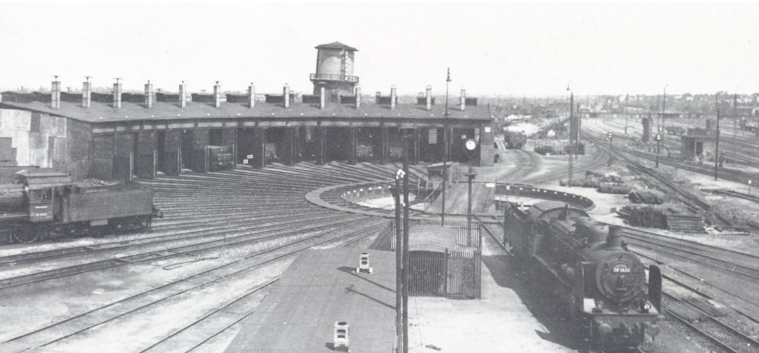
Bild 14: Der Ringlokschuppen und die Drehscheibe des Bw Neumünster aus einem anderen Blickwinkel (20.6.1950). Foto: DB, Sammlung Neumann
