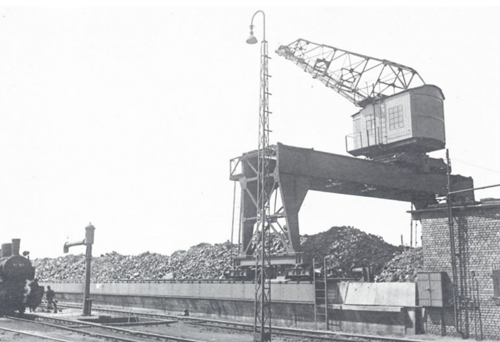
Bild 16: Die Bekohlungsanlage des Bw Neumünster im Jahre 1950. Eine der beiden Kranbrückenschienen ist auf der Wand des Kohlenbansens montiert (siehe auch Bild 18).
