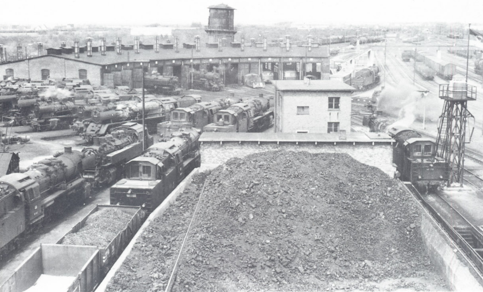
Bild 18: Blick vom Brückenkran auf den Ringlokschuppen am 1. Mai 1962. Wegen des Feiertages wurde auf dem Turmgerüst für den Sand-Hochbehälter die deutsche Flagge gehißt. Das an Feiertagen geringere Verkehrsaufkommen ist sicher auch der Grund dafür, daß im Bw Neumünster so viele Lokomotiven versammelt sind. Auf dem Foto ist übrigens gut zu erkennen, daß die linke Kranbrückenschiene wegen der gebogenen Wand des Kohlenbansens nicht auf der Kohlenbansenwand, sondern innerhalb des Kohlenbansens verläuft (vergleiche auch Zeichnung in Bild 12). Foto: P. Köll, Sammlung Neumann
