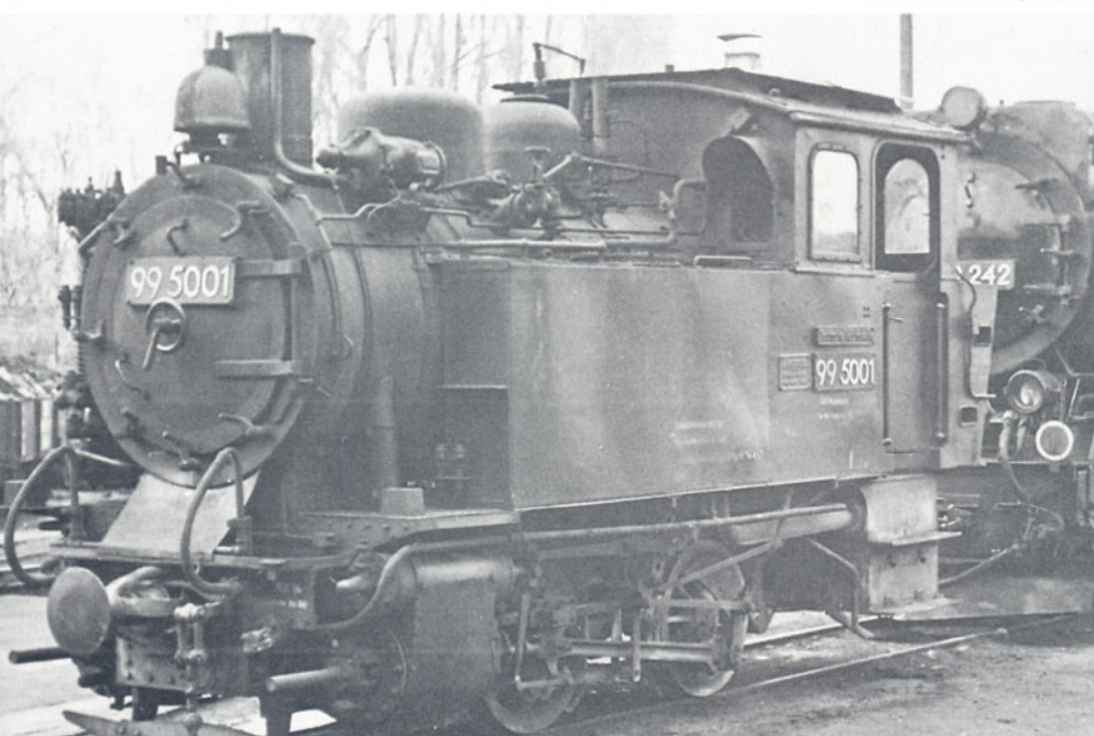
Bild 3: Nach der Einstellung des Betriebs auf der Spremberger Stadtbahn kam die Lokomotive Nr. 11 über das RAW Görlitz als 99 5001 zur Harzquerbahn.
