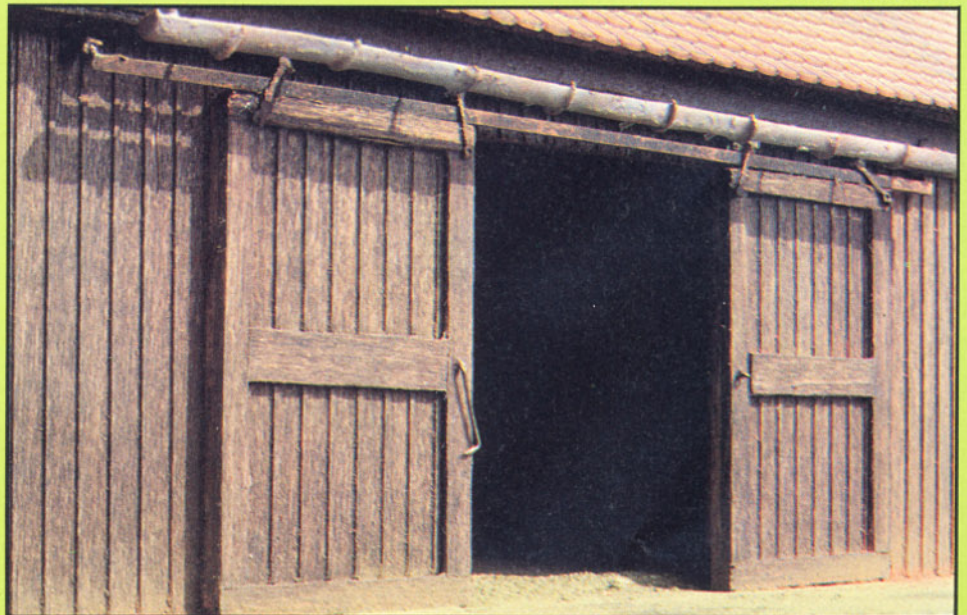
Bild 16: Türdetail: Die Laufrollen der Schiebetüren sind Teile einer Reitz-Kupplung, die auf die Rollen eines Weinert-Rollenhalters gelötet wurden. Für die Dachrinne hat der Erbauer 0,1 mm starke Kupferfolie über 1,5-mm-Rundmaterial gerollt. Die Halter sind aufgelötet.
