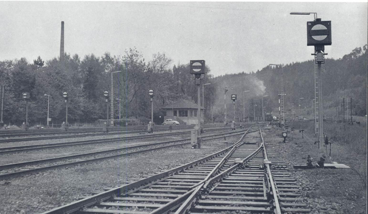
Bild 2: Die nördliche Bahnhofsausfahrt von Schongau mit den beiden Hauptsignalen (links für die Strecke nach Kaufbeuren, rechts für die Strecke nach Landsberg/Lech) sowie insgesamt acht Schutzsignalen; sieben davon sind auf dem Foto zu sehen. Im Hintergrund rechts steigt beim Bahnbetriebswerk „verdächtiger“ Qualm auf (24. 10. 1964). Foto: R. Birzer
