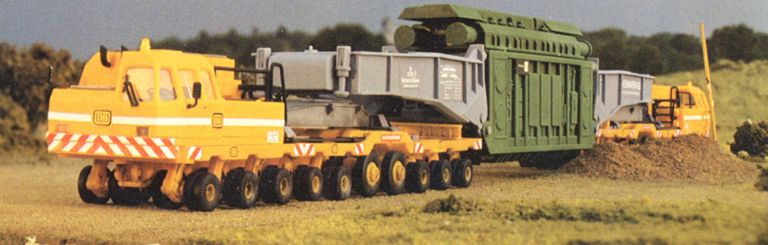
Bild 9: Nach langer nervenaufreibender Fahrt ist das Ungetüm auf der Baustelle eingetroffen. Auf dem vorplanierten Gelände wird nun der Trafo an der vorbestimmten Stelle abgesetzt.
