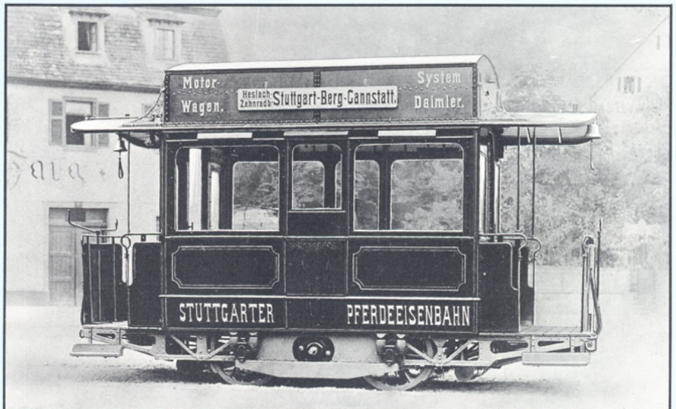
Bild 25: Aufgrund des Versuches von 1887 wurde 1888 von Daimler ein Pferde-Eisenbahnwagen der Heslach Straßenbahn Stuttgart-Berg – Cannstatt nach System Daimler-Benz motorisiert.
