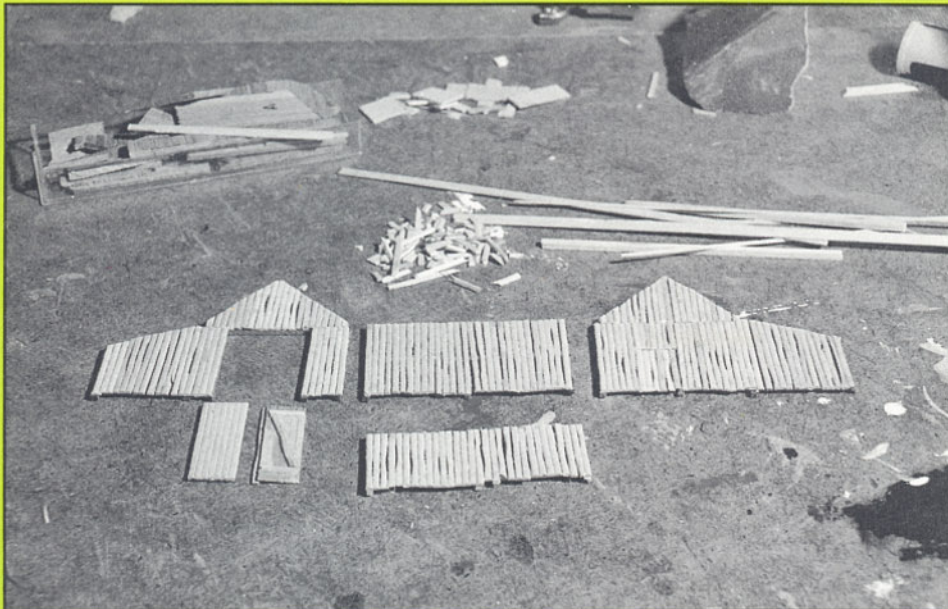
Bild 5: Die mit Holzplatten verkleideten Seitenwände der Scheune.
