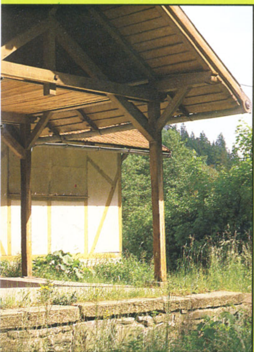
◀ Bild 10: Balkenkonstruktion zur Abstützung des Rampendaches im Original.
