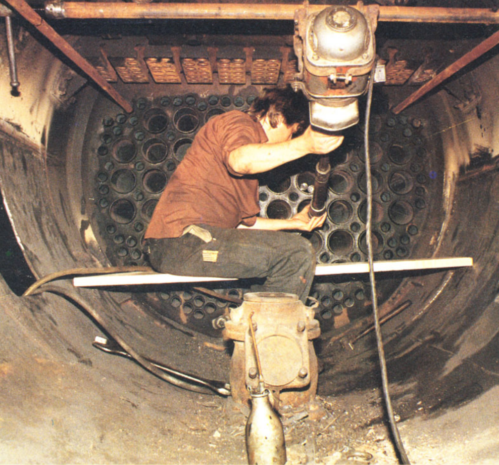
Bild 13: Die Rauch- und Heizrohre werden in die Rauchkammerrohrwand eingewalzt.
