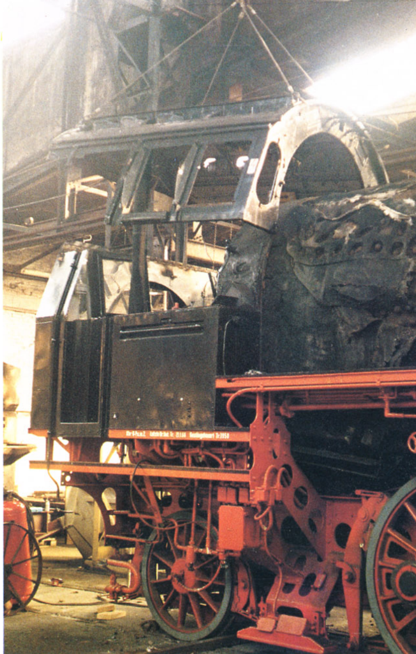
Bild 4: Das Führerhausdach der 23 105 wird abgehoben.
