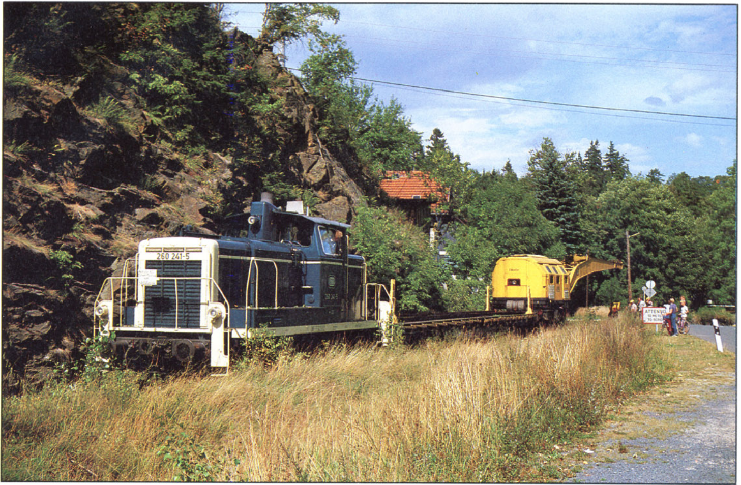
Bild 11: Am 6. September 1982 begannen die Abbrucharbeiten an der Grenze zur DDR in Bleichschmidtenhammer. In Höhe der Straßenleuchte befindet sich im Gleiskörper der Sperrbalken.
