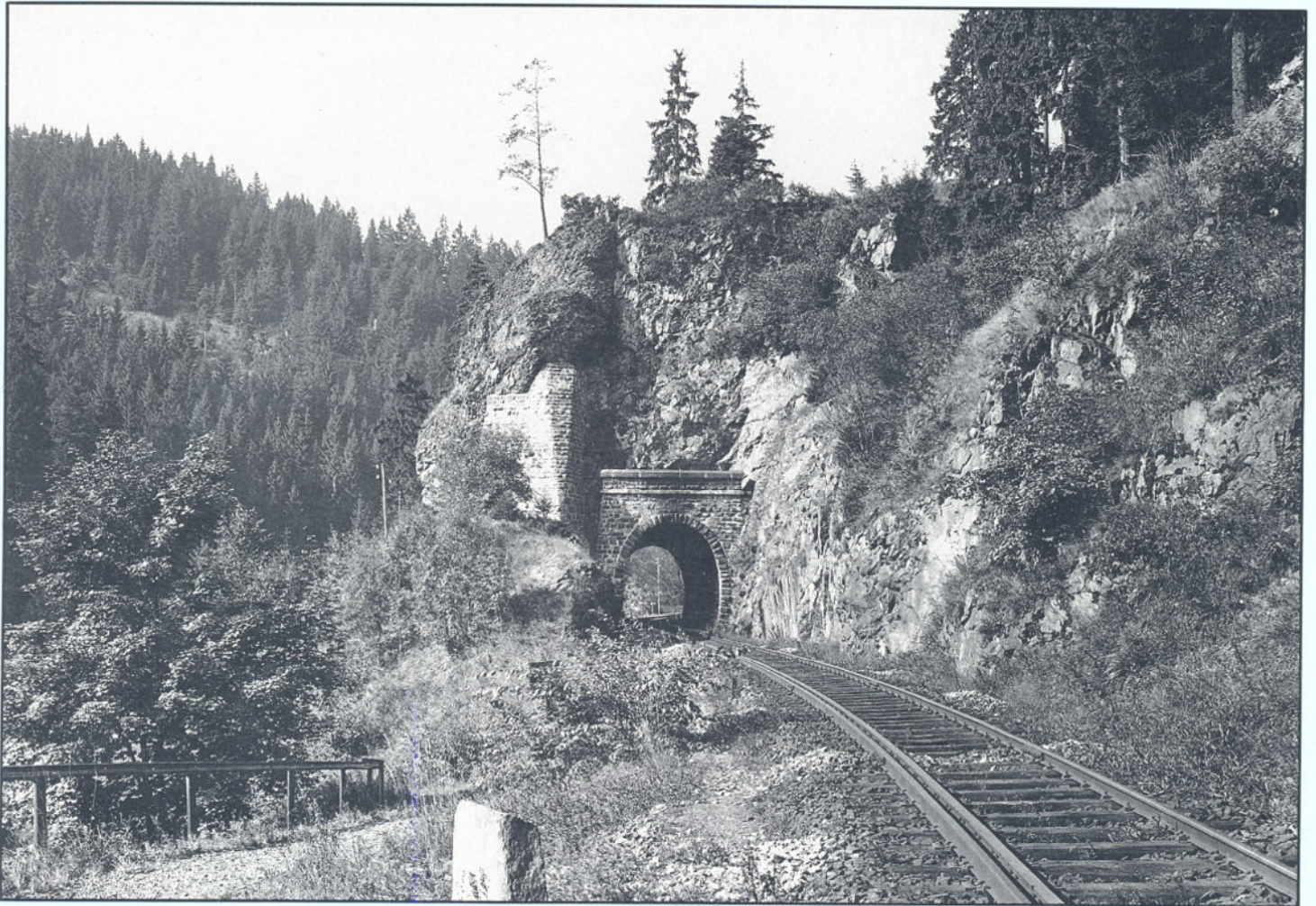
Bild 9: Südportal des Kanzelfelstunnels am 1. 9. 1926, nun mit einem zusätzlichen Stützmauerwerk links oberhalb des Portals.
