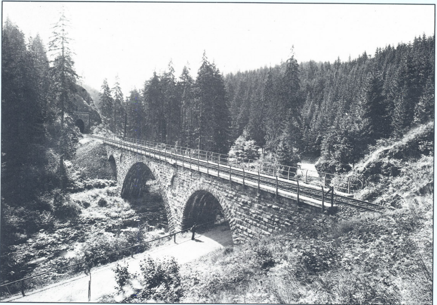
Bild 14: Eine weitere Ansicht der Selbitzbrücke zwischen dem Kesselfels- und dem Kanzelfelstunnel (links) aus dem Jahre 1906.
