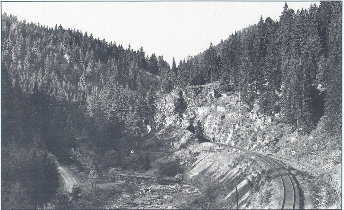
Bild 7: Blick ins Höllental aus Richtung Hölle mit dem Kanzelfels- und links dahinter dem Kesselfelstunnel (1906).
