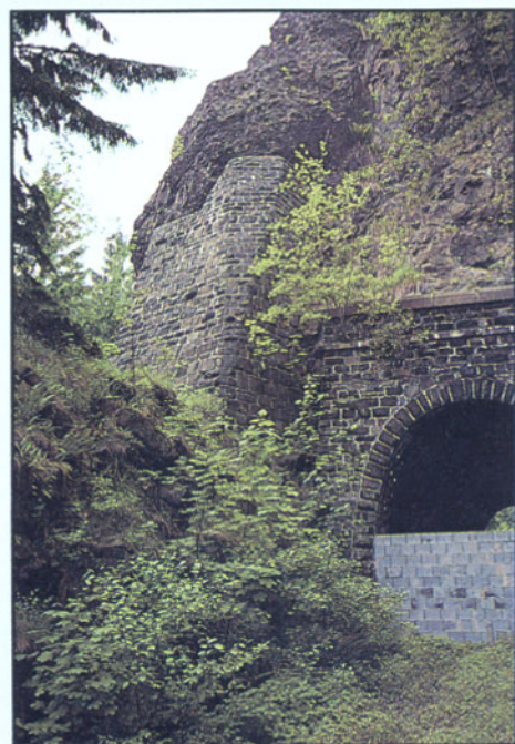
Bild 12: Das jetzt teilweise zugemauerte Südportal des Kanzelfelstunnels.
