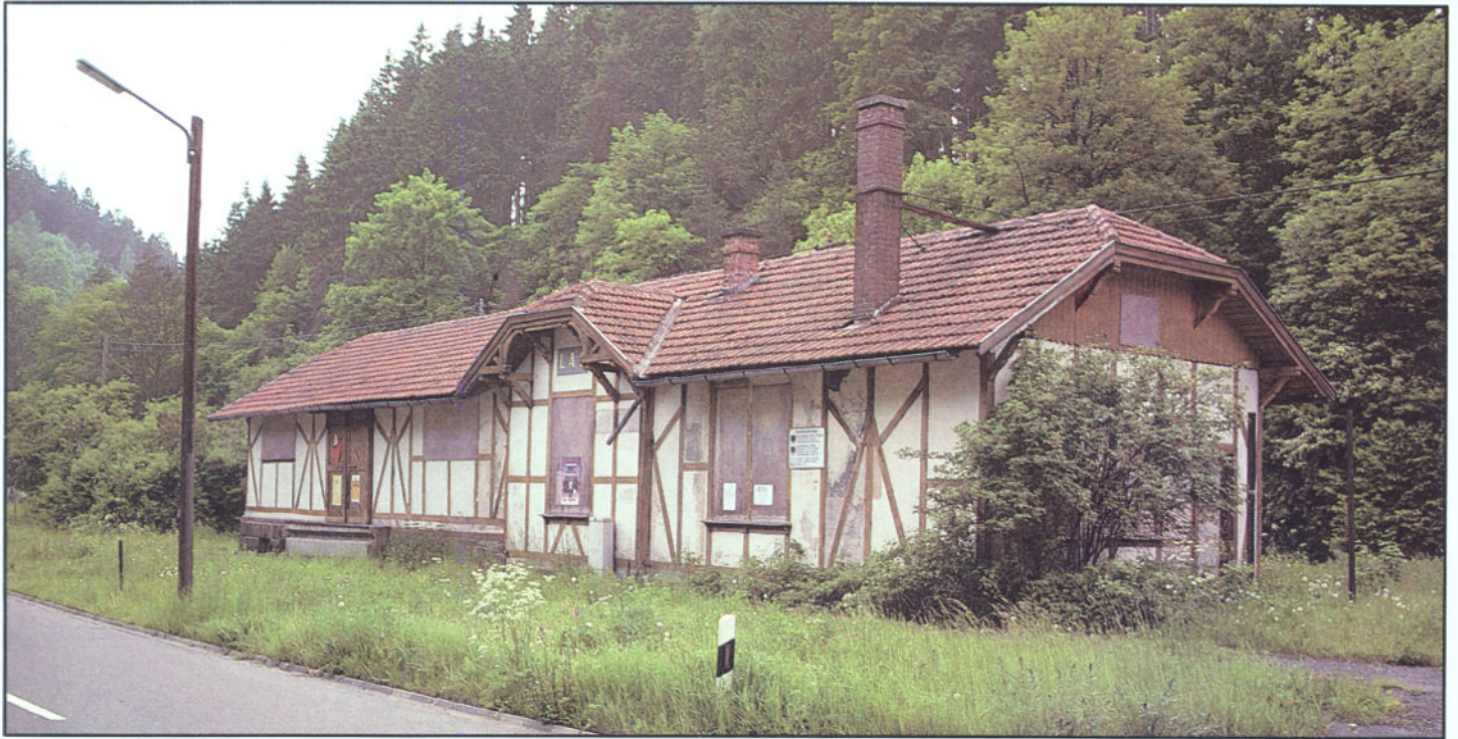
Bild 5: Empfangsgebäude in Lichtenberg.
