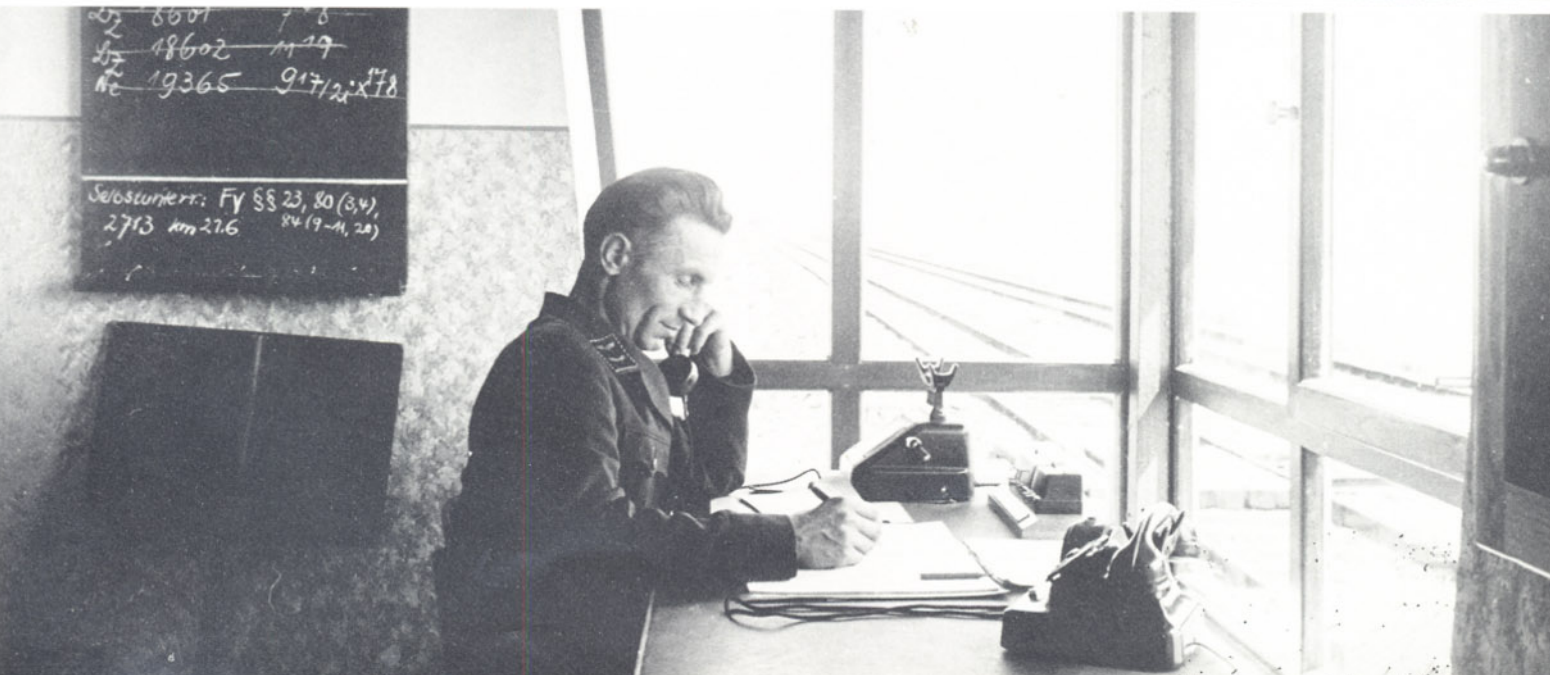
▼ Bild 8: Nach dem zweigleisigen Ausbau des Hindenburgdammes in den 70er Jahren wurde der Kreuzungsbahnhof Hindenburgdamm wieder zur Blockstelle „degradiert“. Das Foto zeigt einen Stellwerker bei seinem Dienst im neuerrichteten Kreuzungsbahnhof Hindenburgdamm am 21.7.1956.
