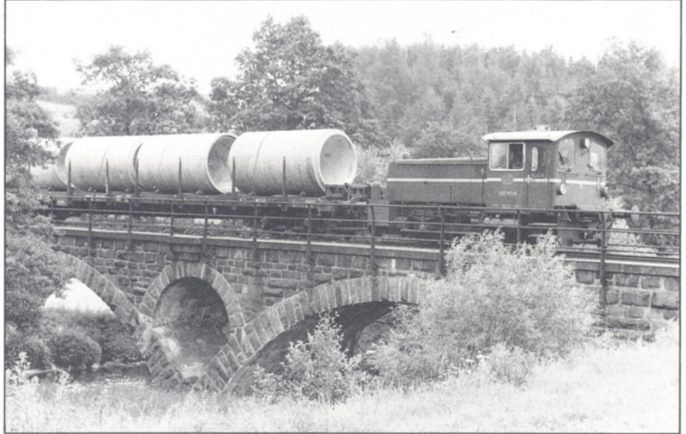
Bild 2: Eine Köf III mit einer Waggonladung Röhren überquert die Selbitzbrücke zwischen den Stationen Marxgrün und Lichtenberg. Foto: S. Winkler
