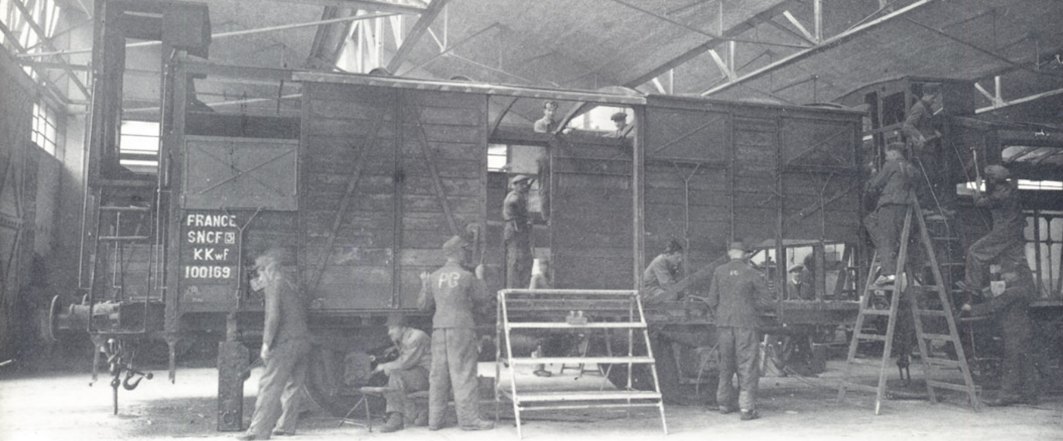
Bild 3: Eine Arbeitspartie während der Montage der Seitenwände und Dachhaut. Einige Arbeiter sind deutsche Kriegsgefangene, kenntlich an der Aufschrift „PG“ = Prisonier de guerre am Rücken. Alle Fotos: Sammlung Stockklausner
