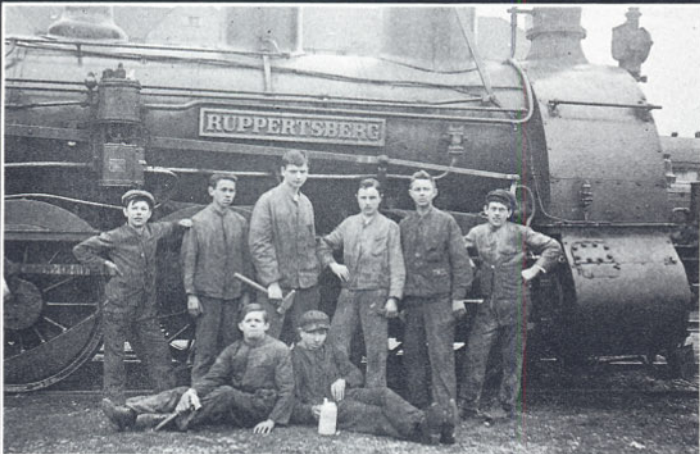
Bild 5: Eine der beiden Probelokomotiven der Verbundausführung der Gattung C IV und zugleich Bayerns erste Verbundlok überhaupt, war die Betriebsnummer 911, „Ruppertsberg“, bei der der große Niederdruckzylinder gut zu sehen ist.
