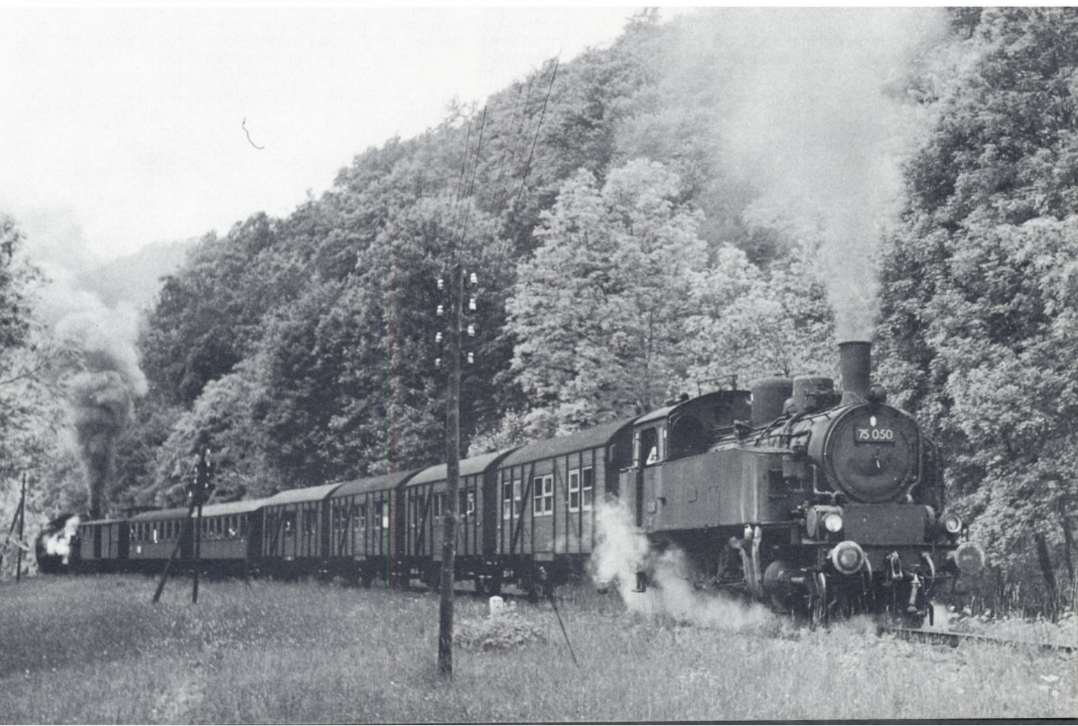
Bild 4: Die steilste Bahnstrecke Württembergs war die Strecke von Honau nach Lichtenstein mit einer Neigung von maximal 1:10. Dort mühte sich die 75 050 am 30. Mai 1958 bergwärts, unterstützt von der kräftigen Zahnradlokomotive 97 501 am Zugende.
