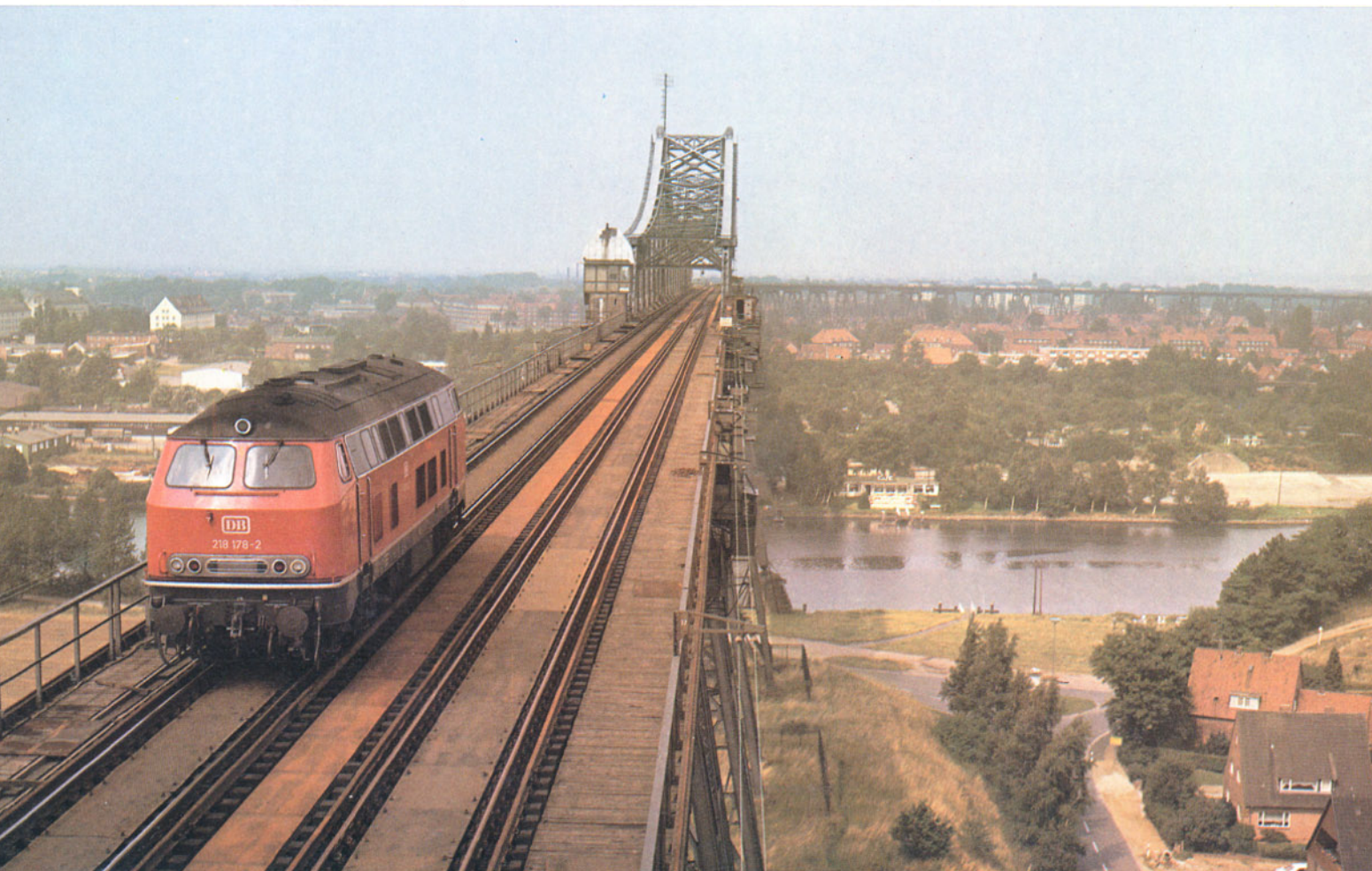
Bild 15: Die Bahnbetriebswerke Flensburg und Lübeck beheimenten die in Schleswig-Holstein eingesetzten Diesellokomotiven der Baureihe 218. Die 218 178 wurde am 25. August 1974 bei einer Lz-Fahrt über die Rendsburger Hochbrücke im Bild festgehalten. Foto: J. Nelkenbrecher
