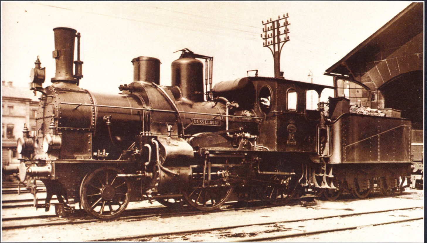
Bild 1: Die „Düsseldorf“ und die „Heidelberg“ (siehe auch Bild 10) waren die beiden letzten B X, die 1891 als Betriebs-Nummern 941 und 942 beschafft wurden. Sie waren zu Vergleichszwecken ursprünglich als Zwillingmaschinen entwickelt worden, wurden jedoch bereits 1893 zu Verbundlokomotiven umgebaut. Foto: Sammlung Dr. Scheingraber
