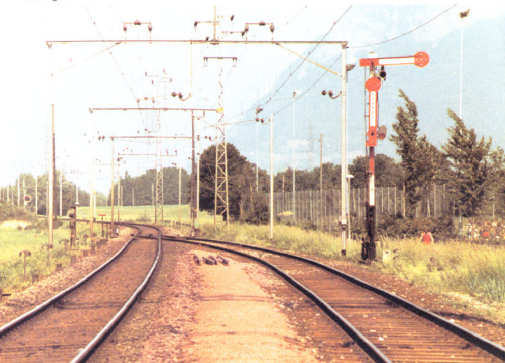
Bild 3: Zu den letzten rechts angeordneten Signalen bei der SBB gehört das Ausfahrtsignal des Bahnhofs Maienfeld in Richtung Bad Ragaz.
