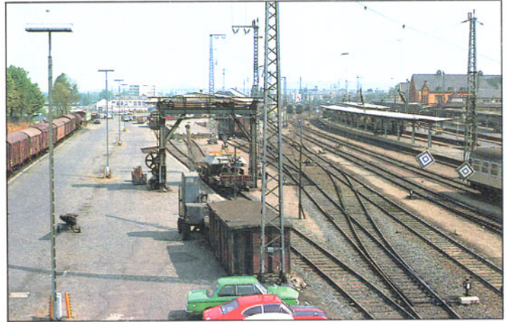
Bild 11: Ladestraße des Bahnhofs Giessen als Beispiel für die Ausgestaltung einer Ladestraße und als Vorschau auf einen entsprechenden Artikel: Zu erkennen sind unter anderem: Förderband, Gabelstapler, Lademaß, Überladekran, Fuchslader, Wagenkasten eines G 10 als Geräteschuppen, Lichtmasten mit Rammschutz aus Schienenprofilen und im Hintergrund eine kombinierte Kopf- und Seitenrampe sowie Kleincontainer. Foto: U. Fetzer
