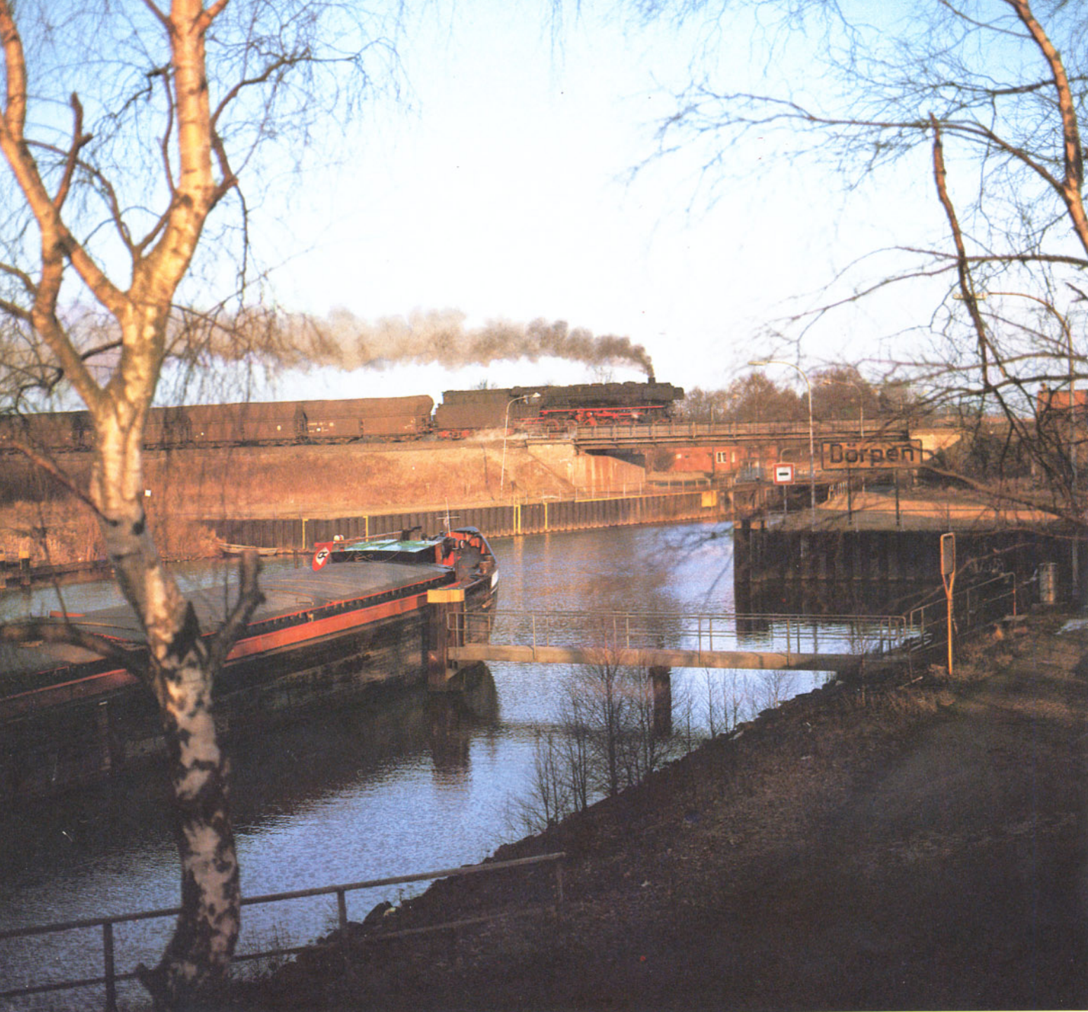
Bild 1: Der Küsten-Kanal, der im Nordwesten Niedersachsens Ems und Weser verbindet, mündet westlich von Dörpen in die Ems. Bei Dörpen wird er von einer Eisenbahnbrücke überspannt. Hier verläuft die Hauptstrecke Rheine – Emden, die Emslandstrecke. Eine ölgefeuerte 043 überquert auf diesem Foto soeben mit einem Güterzug die Brücke (8. 2. 1975).
