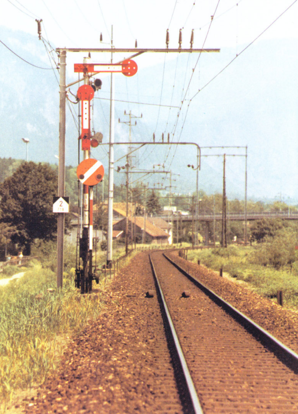
Bild 2: Auch das Einfahrtsignal von Maienfeld aus Richtung Bad Ragaz steht links vom Gleis. Es ist übrigens mit kurzen Signalflügeln ausgerüstet.
