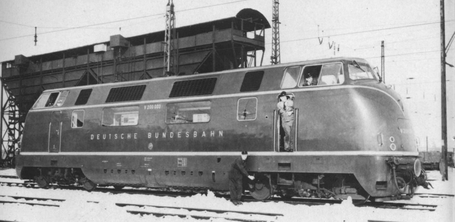
Bild 1: V 200 003 im Februar 1955 vor der Bekohlungsanlage des Bw München Hbf.
