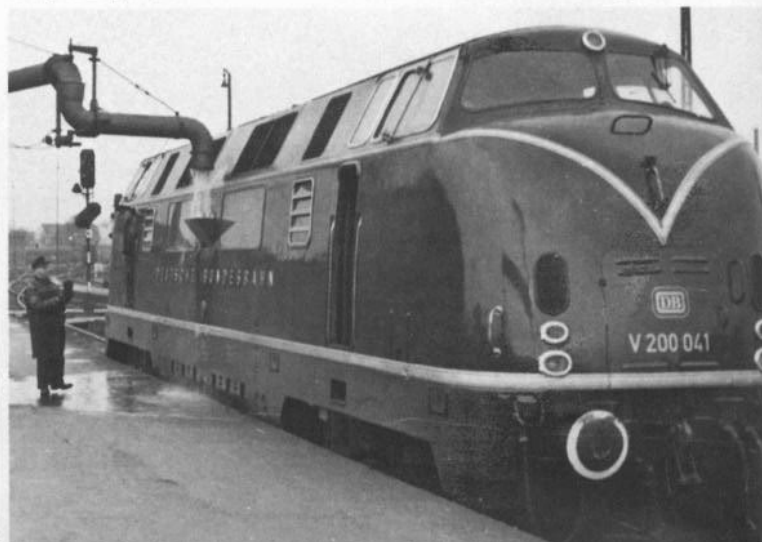
Bild 10: Auch Dieselloks der Baureihe V 200 benützten früher in Ausnahmefällen die damals überall vorhandenen Wasserkäne. V 200 041 beim Wassernehmen für den Heizkessel der Dampfheizung in Hannover.
