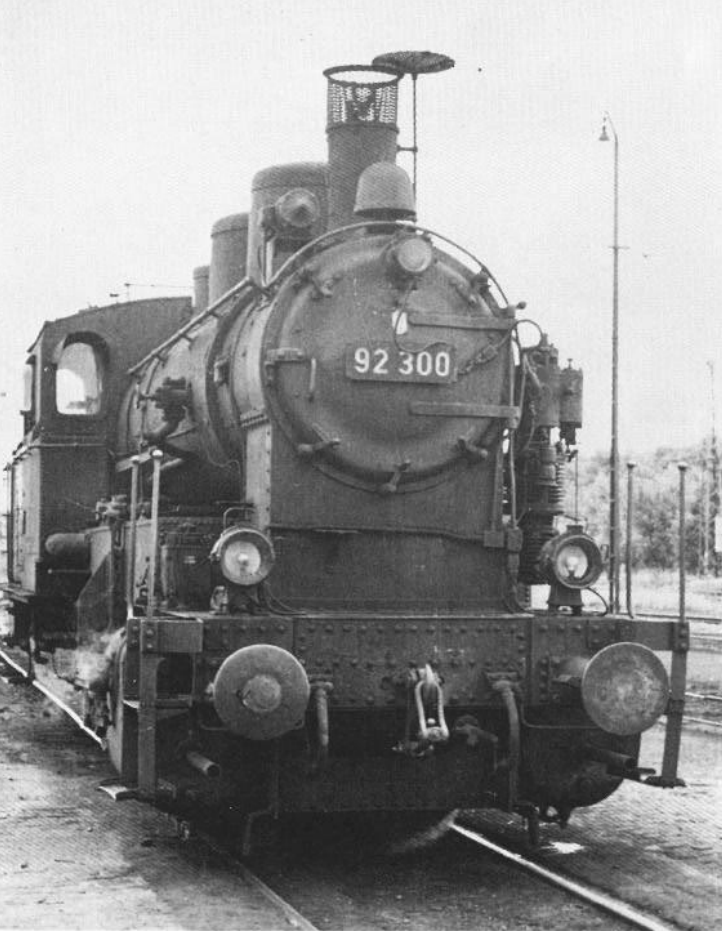
Bild 2: Der Schornsteinaufsatz aus einem Siebblech und der Deckel dienten als Funkenfang.
