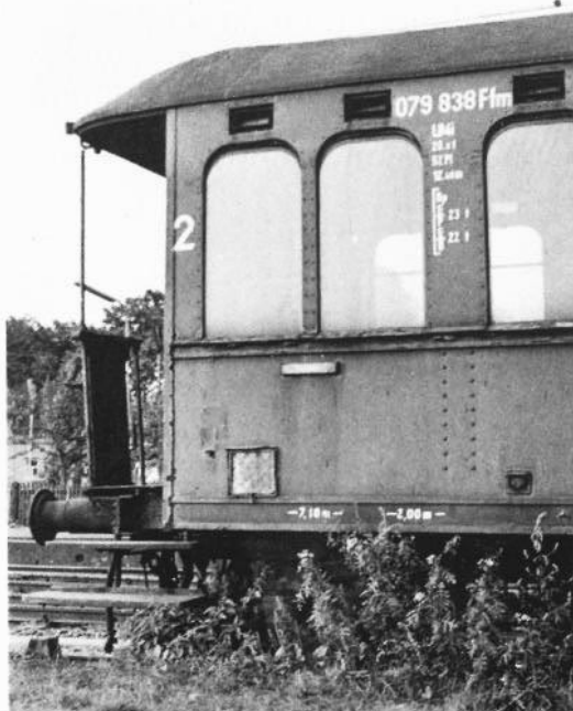
Bild 2: Anschriftenfeld des Langenschwalbachers 079 838 Ffm der Gattung C 41 Pr 09, der noch seine ursprüngliche Fensterausführung behalten hatte. Foto: Ringleb
