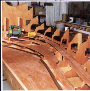
Anlagenrohbau mit Vertikalspannen, Bahn- und Straßentrasse.
