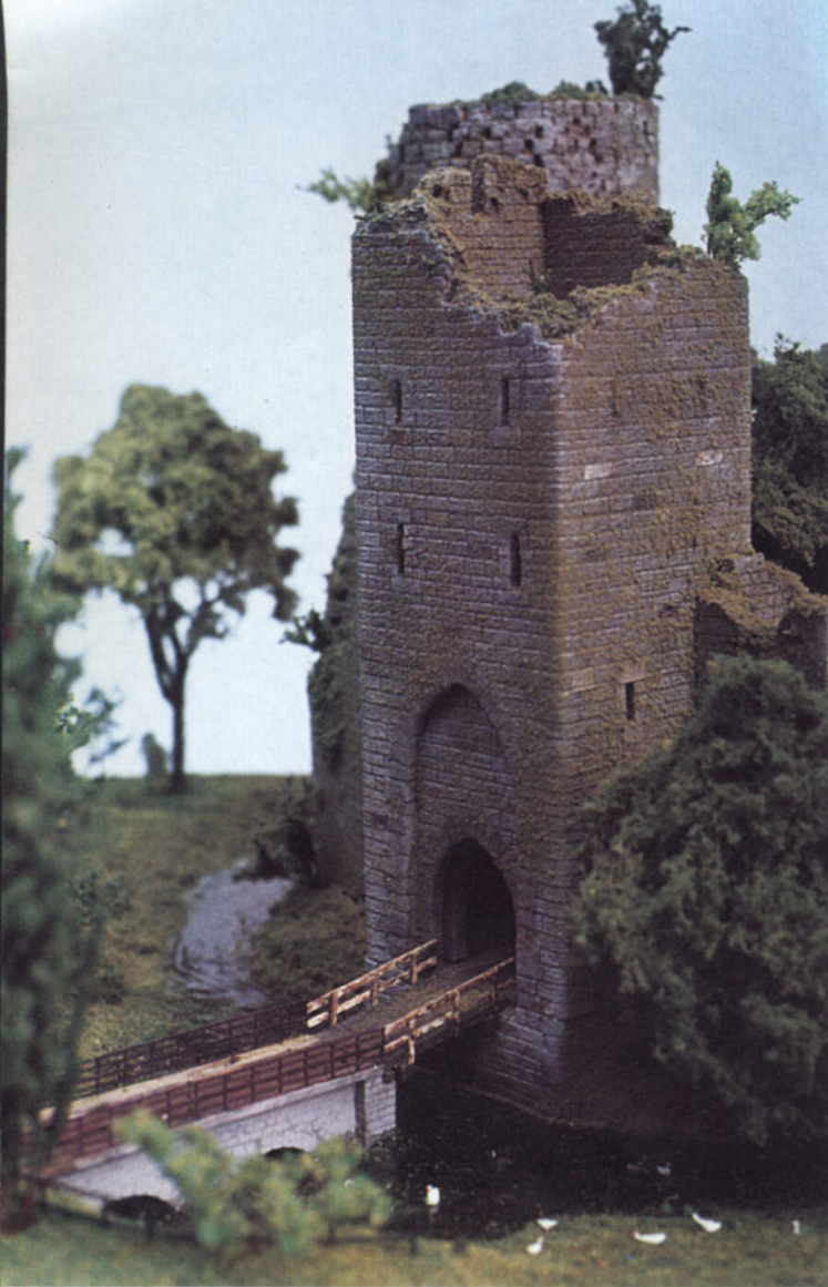
Bild 5: Blick auf den Torturm und die ehemalige Zugbrücke. Die Burg war nach der Erstürmung in wesentlich besserem Zustand als jetzt. In den letzten Jahrhunderten diente die Burg als „Steinbruch“, die Steine dienten für nahegelegene Gehöfte als Mauersteine.
