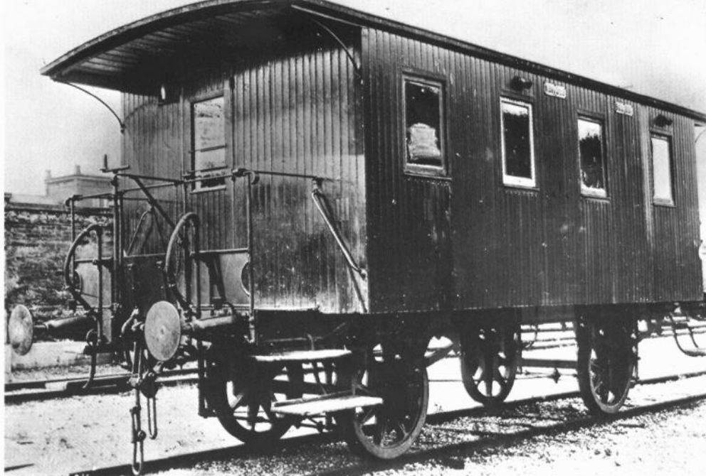
Bild 12: Der BCL bay. 83, wie er bereits auf den vorhergehenden Abb. in Zeichnungen dargestellt wurde. Der Wagen war wohlweise mit und ohne Transportkästen unter dem Wagenboden ausgerüstet. Werkfoto: MAN/Sammlung Dr. Scheingraber
