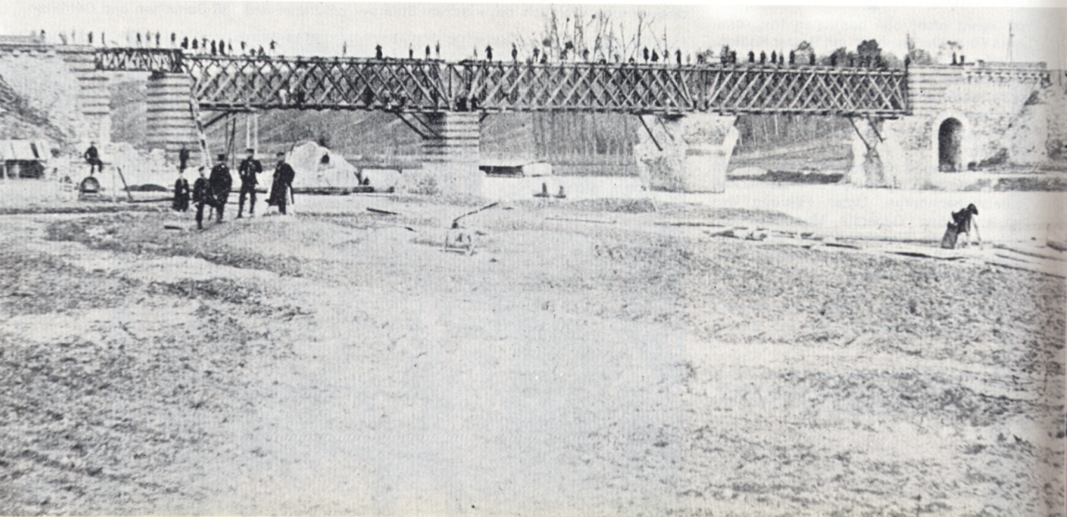
Bild 4: Die unter Mithilfe bayerischer Eisenbahnpioniere wiederhergestellte Eisenbahnbrücke über die Marne bei Trilport nächst Meaux im Oktober 1870.
