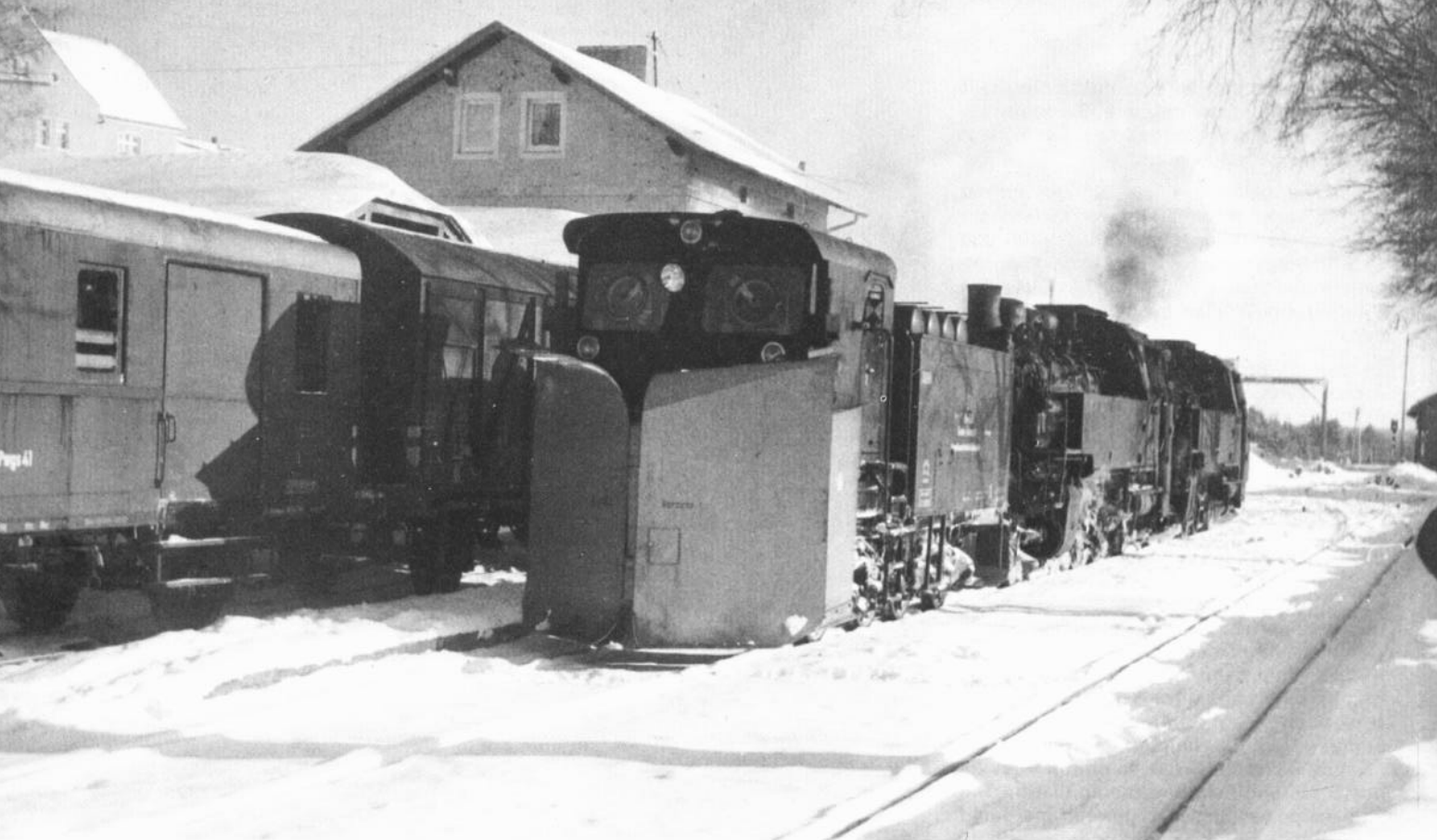
Bild 5: Nach getaner Arbeit im Bahnhof Fichtelberg am Fuße des Ochsenkopfes 1968: die Strecke von Neusorg herauf ist wieder frei.
