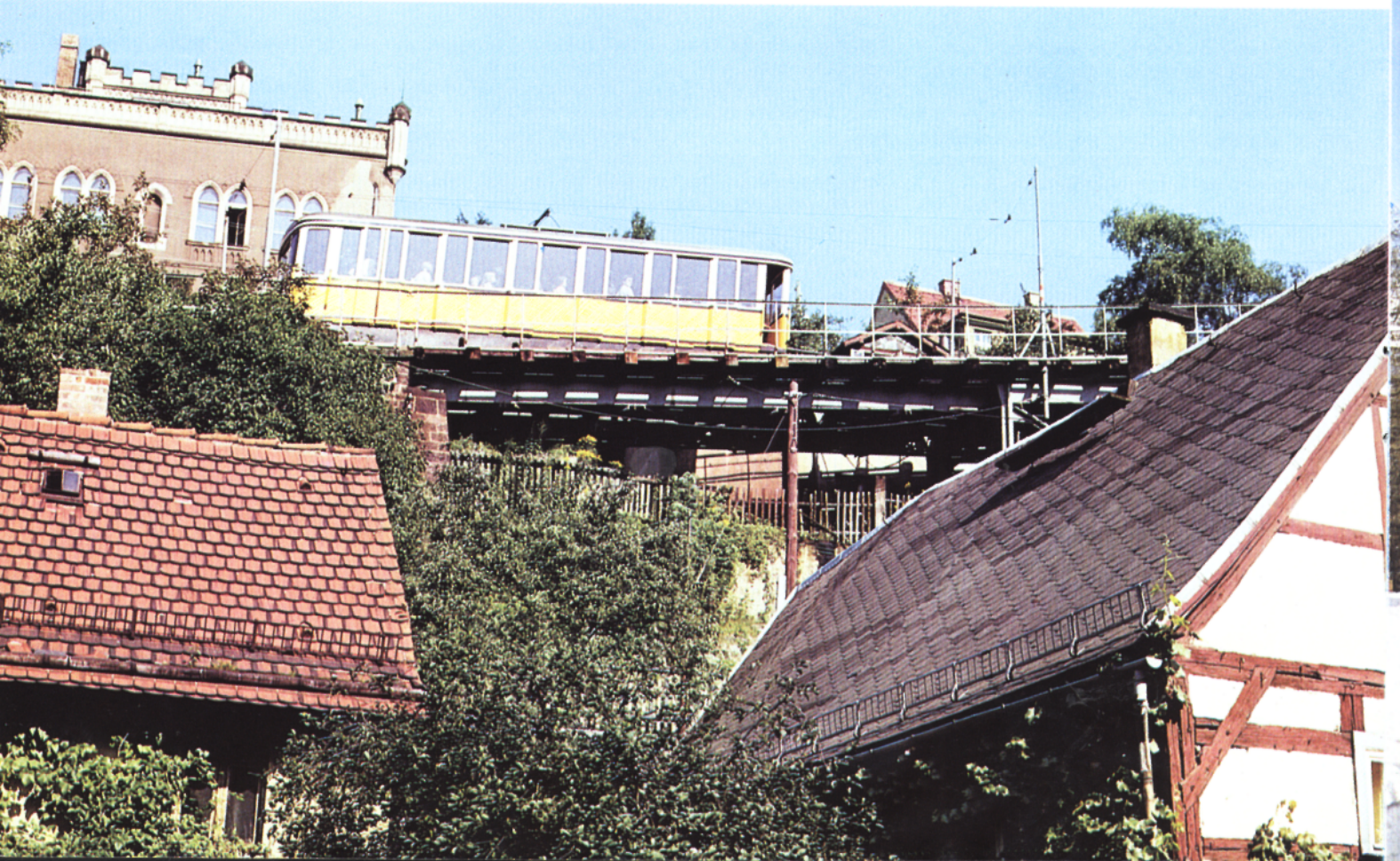
Bild 5: Ein großer Teil der Strecke verläuft über eine Stahlbrückenkonstruktion.
