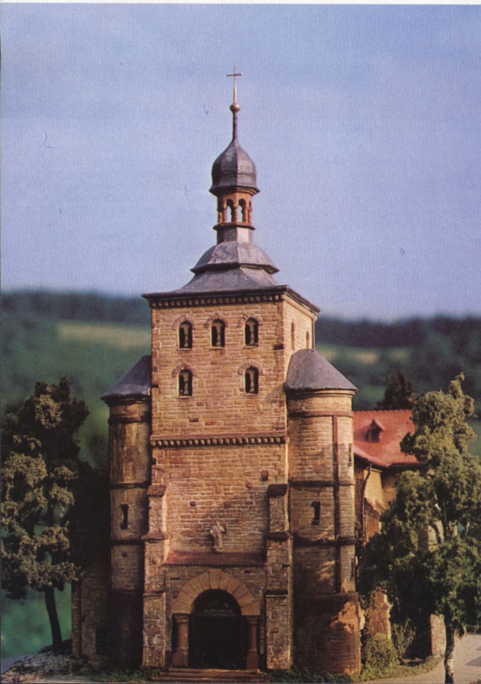
Bild 5: Die Frontansicht zeigt den wuchtigen Turm mit dem Hauptportal und den beiden angebauten Treppentürmen.
