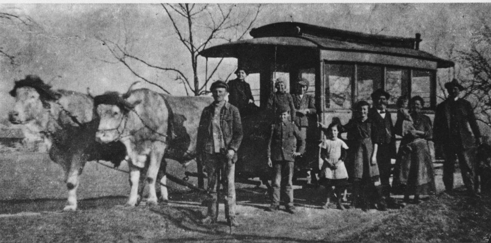
Bild 5: Die Wagen der Pferdebahn wurden nach der Einstellung versteigert. Ein Bauer holte seine Neuerwerbung mit einem Ochsengespann ab.
