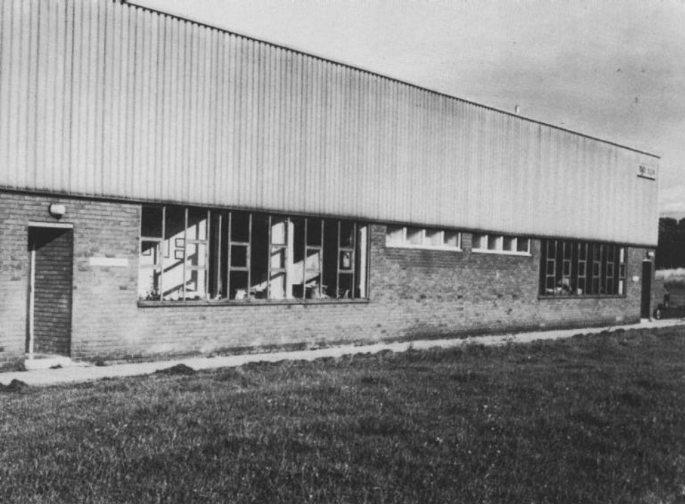
Bild 1: Die neue Heimat von M + F in Consett im englisch/schottischen Grenzland.
