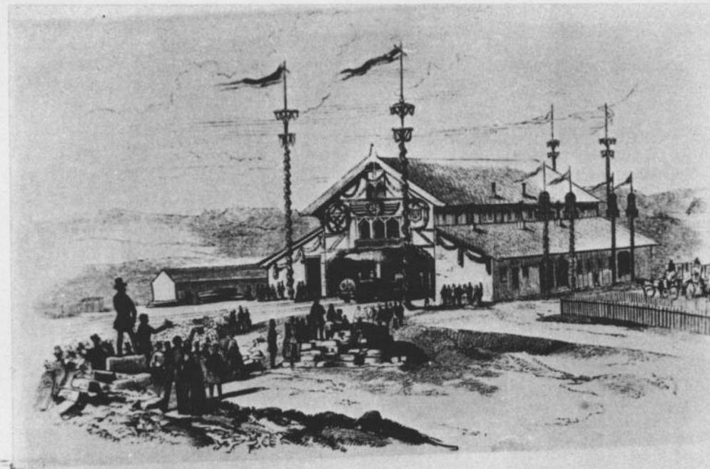
Bild 8: Das provisorische Bahnhofesgebäude (Personenschuppen) des böhmischen Bahnhofs in Dresden um 1850 als zeitgenössischer Stich.
