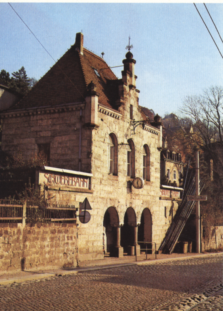
Bild 4: Das repräsentative Empfangsgebäude der Talstation an der Pillnitzer Landstraße.
