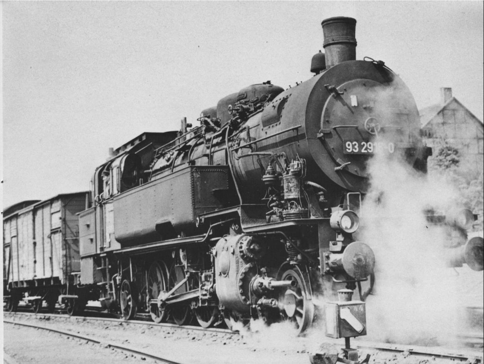
Bild 19: Das Erinnerungsbild für das Personal war auch für den Fotografen die letzte Aufnahme einer T 14 1 unter Dampf. Die Maschine hatte ebenfalls noch genietete Wasserkästen. Unter dem Kohlenkasten markieren die Nietenreihen die Größe des hinteren Wasserkastens.
