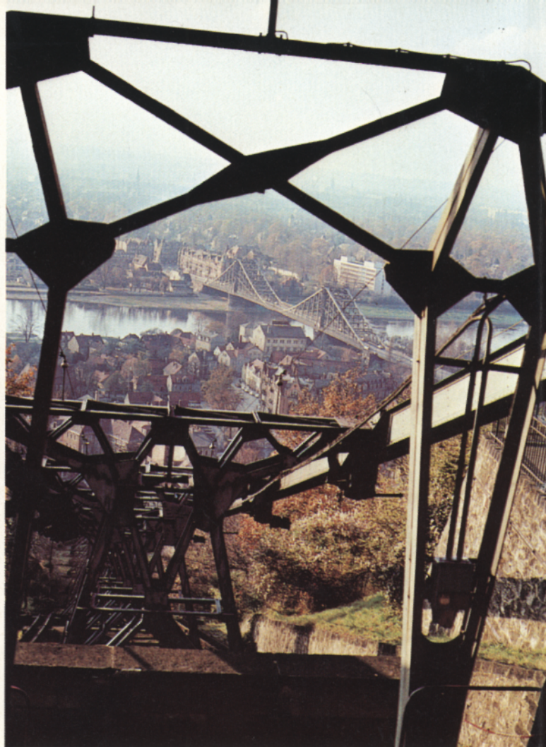
Bild 3: Blick von der Bergstation durch die Tragejochkonstruktion auf Dresdens markanteste Elbbrücke, das 'Blaue Wunder'.
