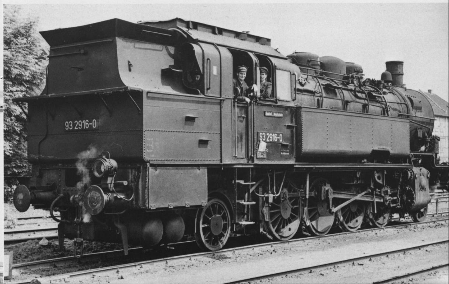
Bild 19: Das Erinnerungsbild für das Personal war auch für den Fotografen die letzte Aufnahme einer T 14 1 unter Dampf. Die Maschine hatte ebenfalls noch genietete Wasserkästen. Unter dem Kohlenkasten markieren die Nietenreihen die Größe des hinteren Wasserkastens.
