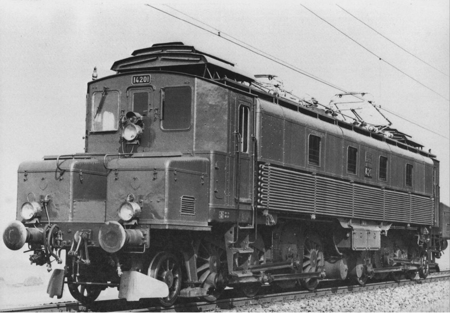
Bild 2: Diese Aufnahme zeigt die Probelokomotivaufnahme Typ Ce 6/8 I die 1920 in einem einzigen Exemplar gebaut wurde. Mit ihrer Achsanordnung bildet sie das Vorbild für alle Krokodil-Lokomotiven.
