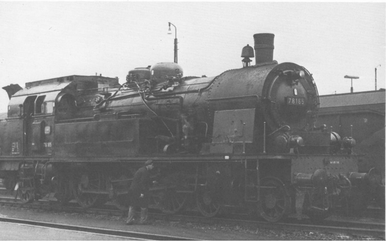
Bild 5: Im Jahr 1966 entstand diese Aufnahme der 78 185 mit zurückverlegtem Dampfdom in Schweinfurt. Davor sind die Speiseventile zu erkennen.
