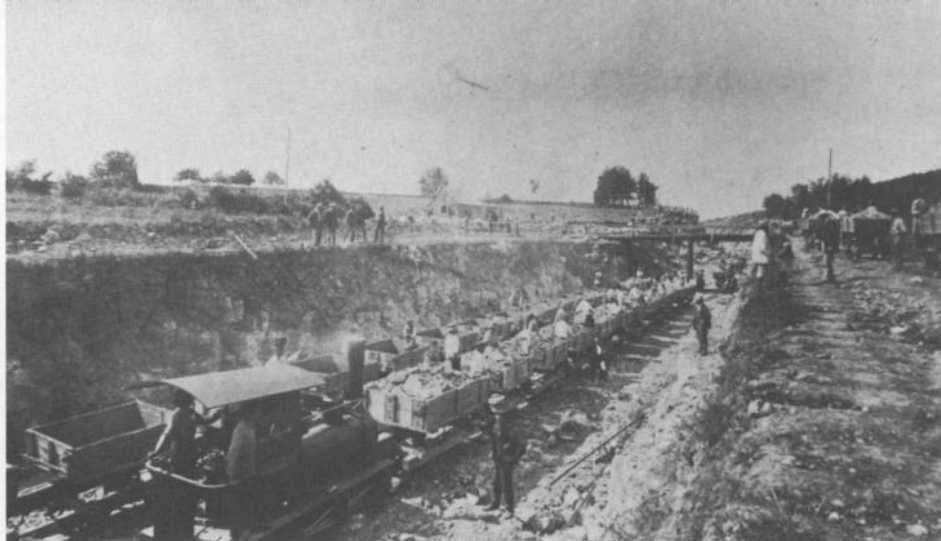
Bild 14: Herstellung des Felseneinschnittes bei Parsberg am 23.08.1871.
