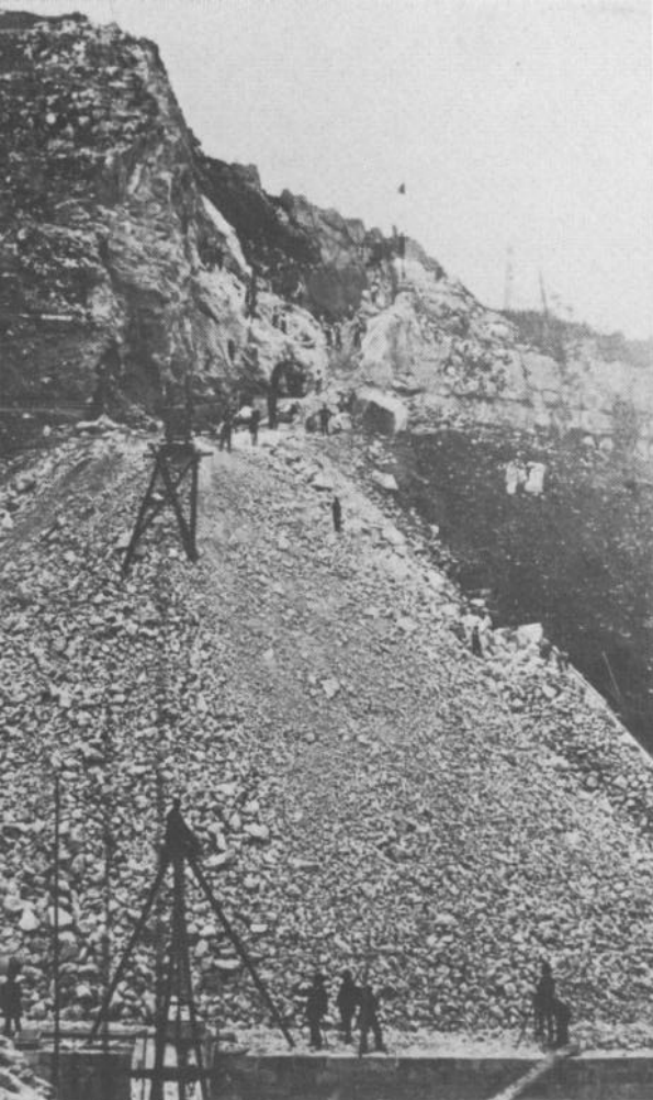
Bild 13: Die Aufschüttung über den Schelmengraben bei Waltenhofen — Etterzhausen am 17.05.1981.
