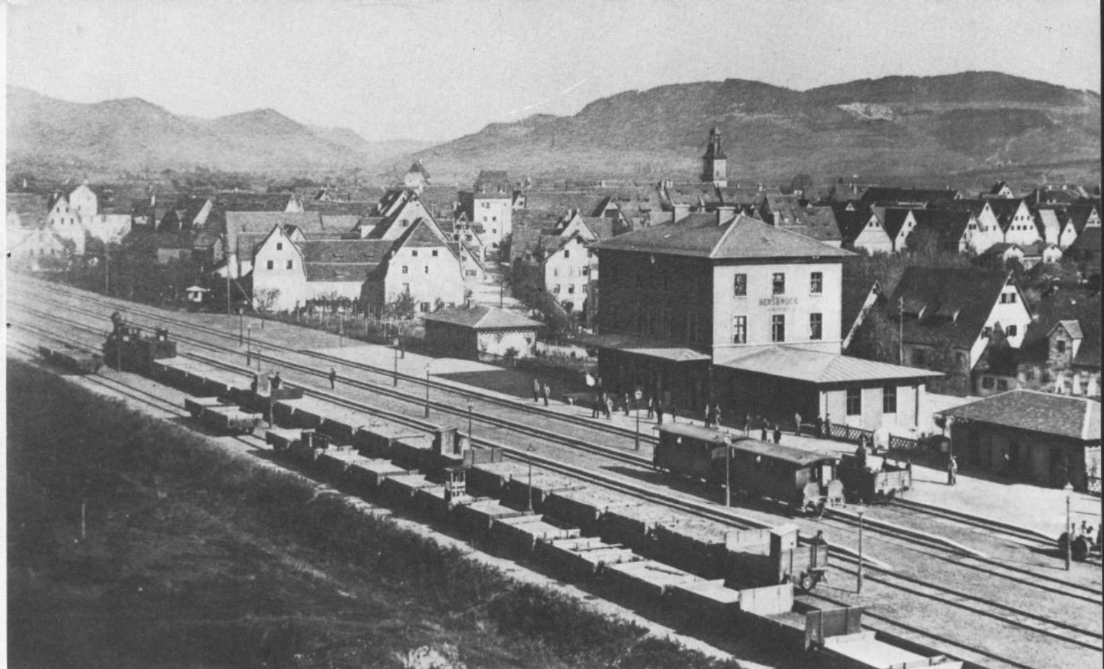
Bild 1: Bis Hersbruck verlaufen die beiden Strecken der ehemaligen Ostbahn bzw. der ehemaligen Bayerischen Staatsbahngesellschaft parallel zueinander. Dieses Foto zeigt einen Blick in den Bahnhof Hersbruck rechts der Pegnitz der Bayerischen Staatsbahngesellschaft im Jahre 1885.
