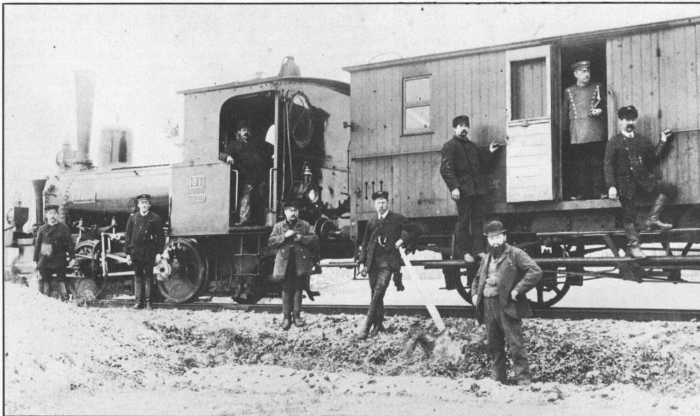
Bild 7: Ein Foto, das wir ausfindig machen konnten, zeigt die D I mit dem Namen Geryon, Bahn-Nr. 656, Lieferjahr 1874. Interessant ist der dahinter befindliche Güter-, Post- oder Gepäckwagen, der in dieser Form in keinem bayerischen Wagenstandverzeichnis nach 1890 mehr auftaucht. Es gibt zwar Wagen mit dem gleichen Fahrwerk, dann aber mit Einstiegsbühnen auf beiden Seiten. Wer kann uns nähere Auskunft über diesen Waggon geben?
