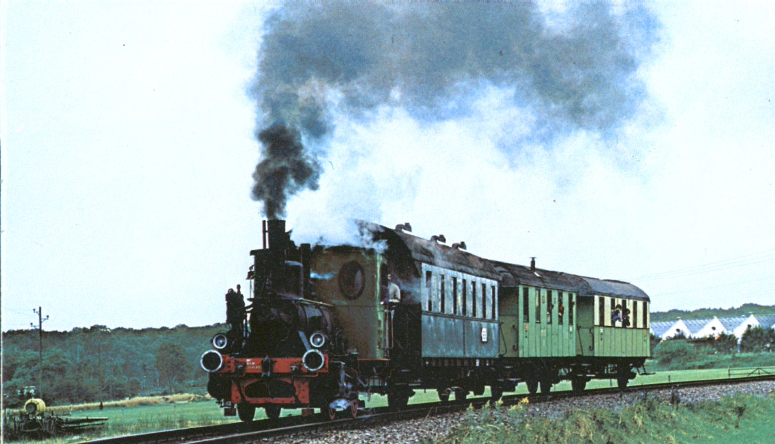
Bild 1: Die »Berg« (Bayerische D VI) mit Museumszug auf der SWEG-Strecke zwischen Walldorf und Wiesloch. Dieses Bild weckt Erinnerungen an alte Lokalbahnzeiten.
