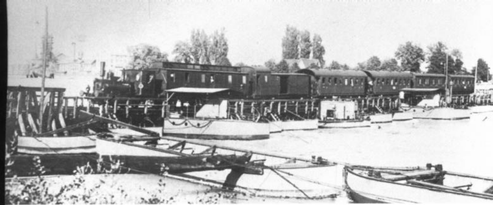
Bild 36: Eine D VI der Baureihe 98 75 mit einem Personenzug bei der Überquerung des Rheins auf einer Schiffsbrücke. Foto: Bellingrodt
