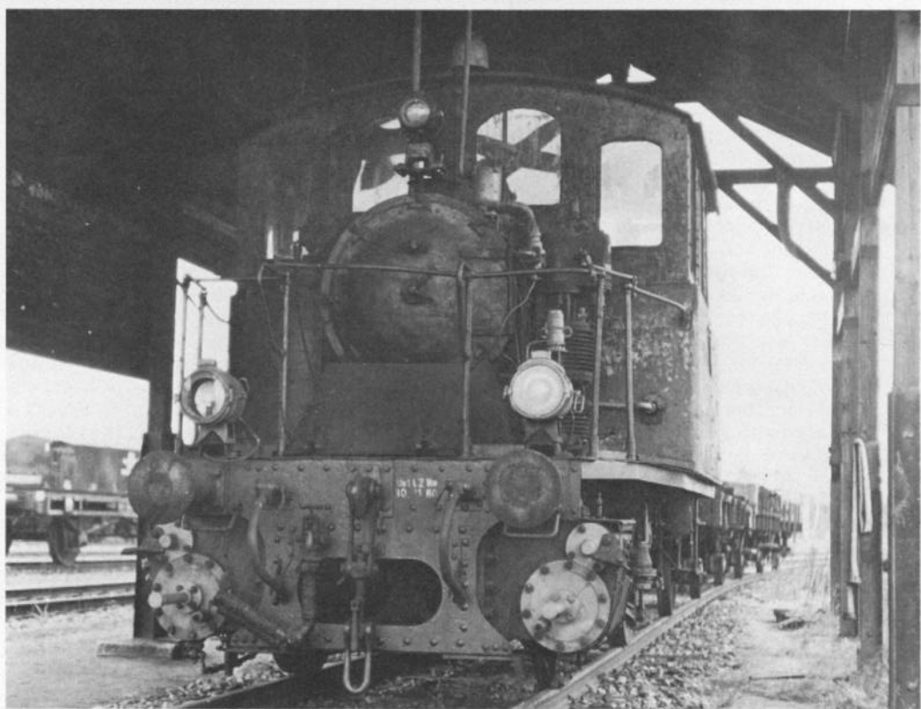
Bild 22: Nach der Ausmusterung der Lokomotive 98 307 war deren Schicksal zunächst noch ungewiß. Vorübergehend blieb sie halb demontiert unter einer Überdachung im AW Nürnberg abgestellt. Foto: H. J. O
