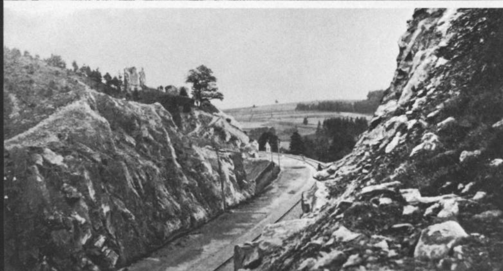
Bild 11: Der tiefe Einschnitt bei Trautenberg zur Zeit des Bahnbaues. Deutlich ist der vorerst nur einspurige Streckenausbau zu erkennen, jedoch ist bereits für das zweite Gleis der notwendige Raum vorgesehen. Die Aufnahme entstand etwa im Jahre 1865. Foto: Verkehrsarchiv Nürnberg
