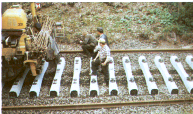
Bild 3: Die Gleisbaumaschine verlegt auf dem vorbereiteten Gleisbett die neuen Betonschwellen. Nach den ersten vier Bahnschwellen sieht man die von den Arbeitern bereits aufgelegten Gummipatten, auf die später die Gleise aufgelegt werden.
