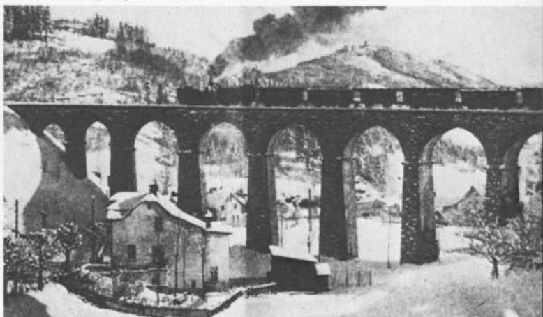
Bild 11: Ein bergauf fahrender Zug mit Lok KkStB 97 auf dem Jettelgrundviadukt. Foto entnommen der Isergebirgsrundschau Kaufbeuren.
