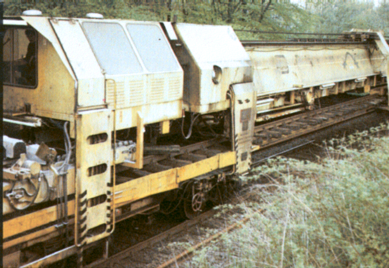
Bild 7: Jetzt wird bereits das alte Gleisjoch auf die Stahlplatte — und das Gleis sozusagen im Parterre der Maschine — nach hinten befördert.
