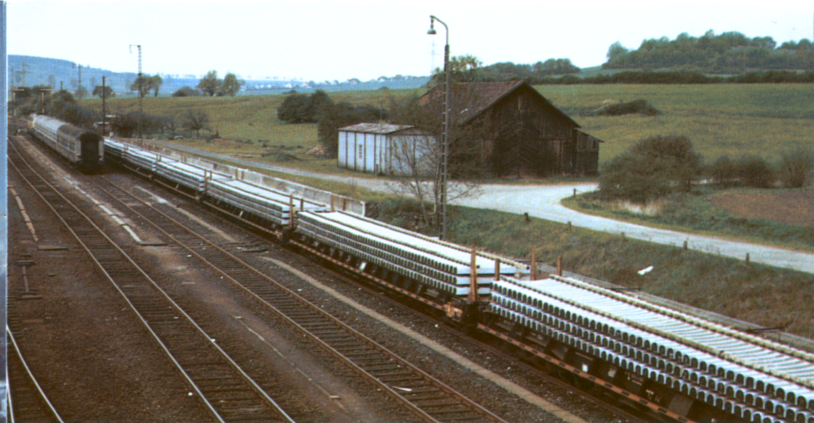
Bild 1 + 2: Der Betonschwellenzug im Bahnhof Lauterbach.
