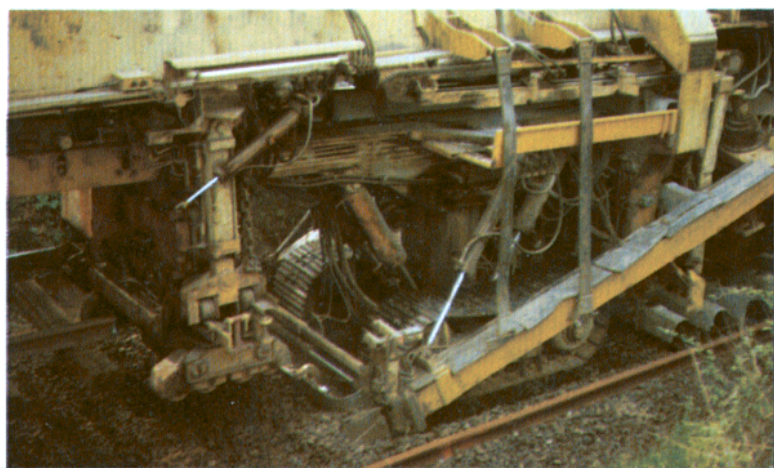
Bild 4: Der mit Raupenketten versehene Vorderteil nimmt durch die schräg führende Vorrichtung den seitlichen Kies auf und setzt gleichzeitig Schwelle für Schwelle auf das Gleisbett, am linken Bildrand kann man gerade noch erkennen, wie das alte Gleis abgehoben wird.
