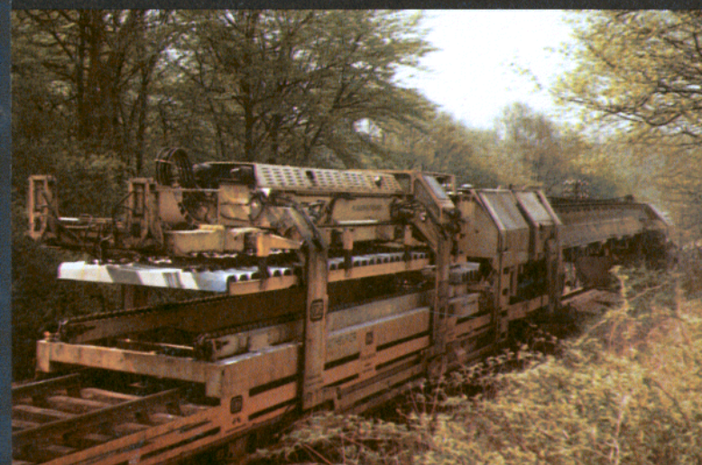
Bild 9: Das Gleisjoch kommt, unter der Maschine auf der Stahlplatte liegend, wieder zum Vorschein, während oben bereits neue Schwellen aufgesetzt werden.
