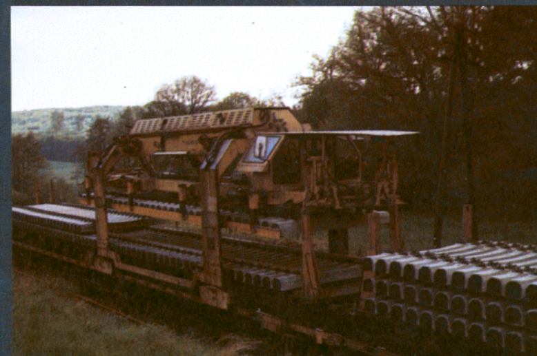
Bild 13: Die neuen Schwellen sind aufgenommen.
