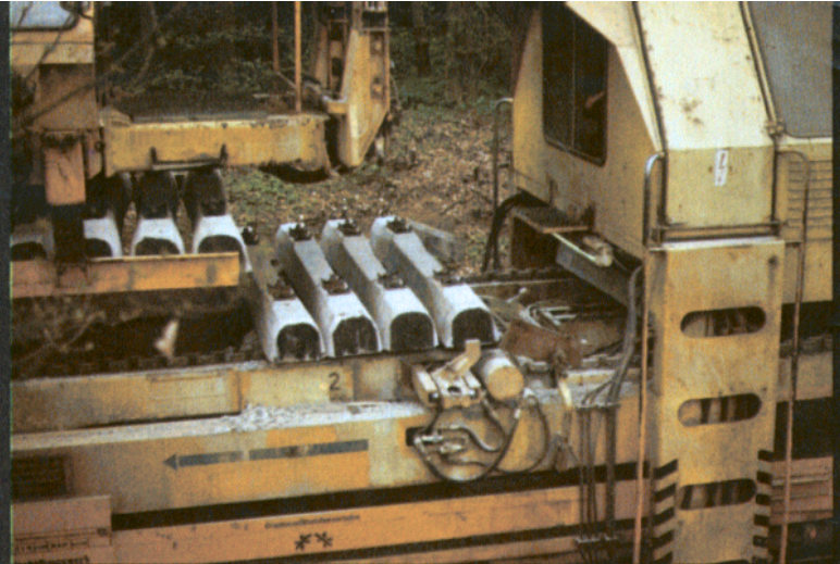
Bild 6: Am hinteren Ende der Maschine werden die letzten vier auf den Transportketten liegenden Schwellen der Maschine zugeführt, während der Portalkran eine neue Ladung Schwellen anliefert.
