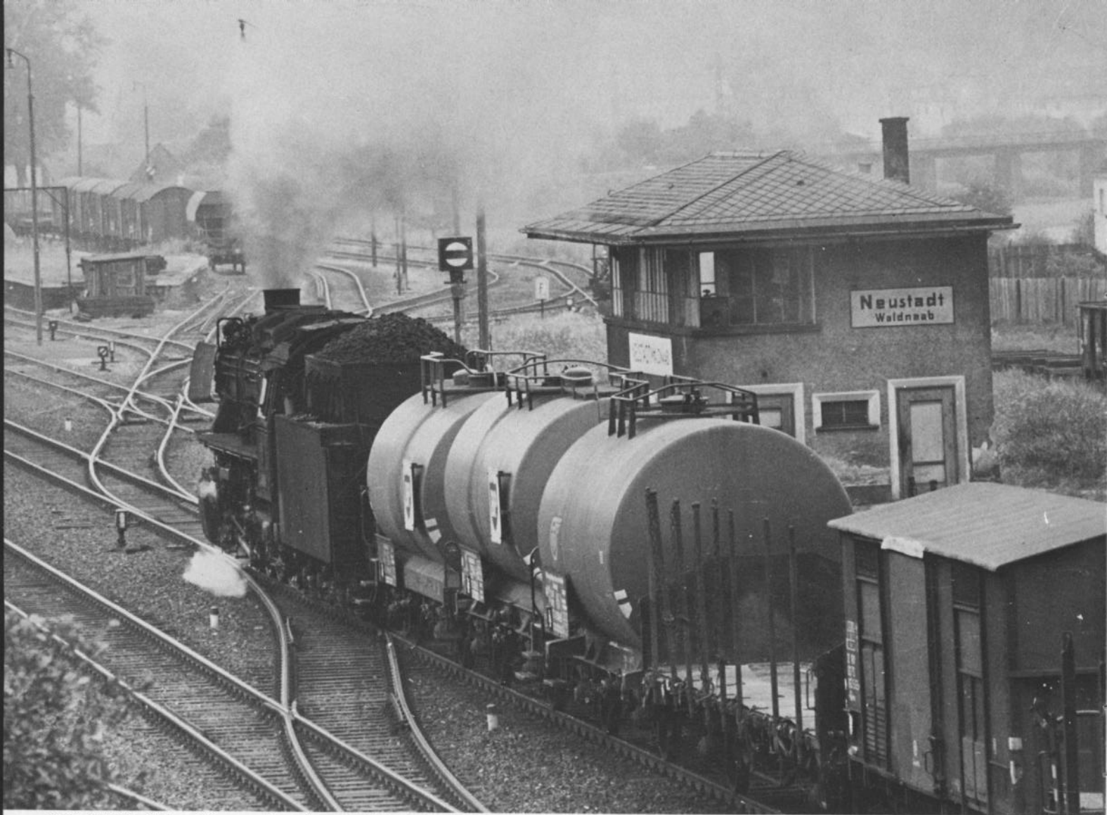
Bild 28: 044 412-5 mit einem Güterzug von Regensburg nach Marktredwitz durchfährt Neustadt an der Waldnaab am 17.8.1972. Rechts oben im Hintergrund die Abzweigung, die über die noch schwach sichtbare Waldnaab-Brücke nach Eslarn führt. Foto: R. Haardt
