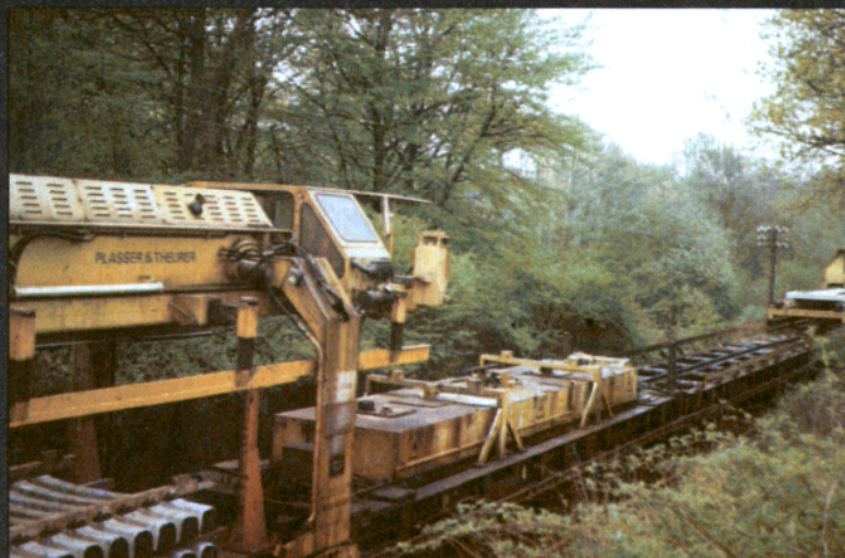
Bild 12: Die Transportplatte ist bereits zur Maschine zurückgekehrt und ein Kran ist bereit, neue Schwellen zu holen.
