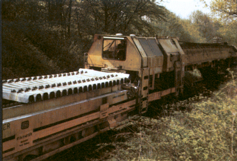
Bild 8: Nun kann bereits das nächste Gleisjoch abgehoben werden.
