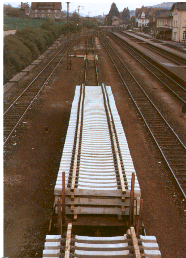
Bild 3: Die Gleisbaumaschine verlegt auf dem vorbereiteten Gleisbett die neuen Betonschwellen. Nach den ersten vier Bahnschwellen sieht man die von den Arbeitern bereits aufgelegten Gummipatten, auf die später die Gleise aufgelegt werden.
