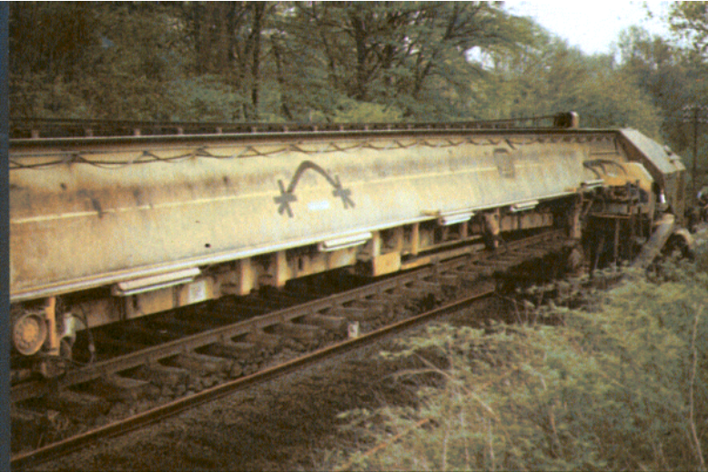
Bild 5: Hier ist ein Teil der beachtlichen Maschinenlänge gut sichtbar. Das alte Gleisjoch wird angehoben.
