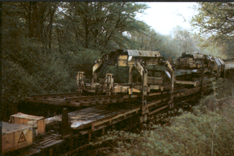
Bild 11: Das Gleisjoch wird von der Transportplatte gehoben und über den anschließenden Spezial-Flachtankwagen hinweg befördert.
