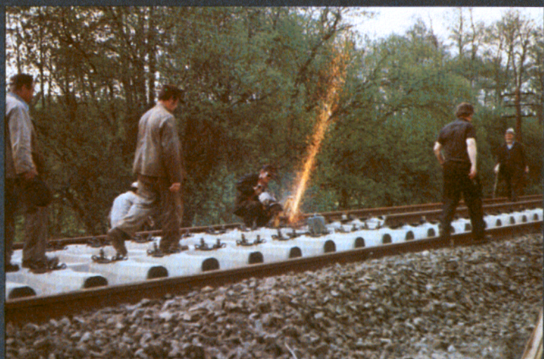
Bild 16: Die neuen Gleisprofile werden aufgelegt und auf Passung zugeschnitten.
