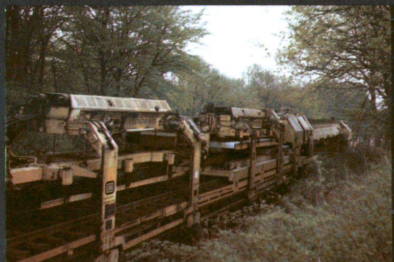
Bild 10: Nun steht bereits der zweite Portalkran bereit, um das alte Gleisjoch zum Weitertransport an das Ende des Zuges aufzunehmen.
