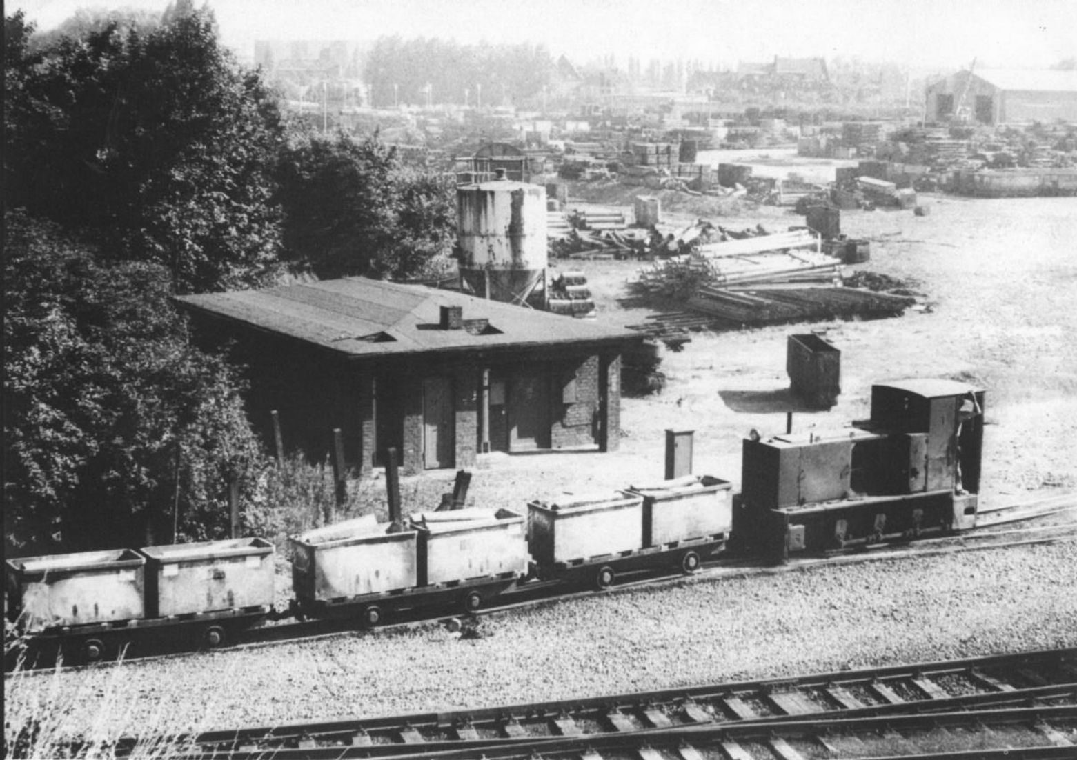
Bild 1: Loknummer 1 auf der Fahrt zum im Hintergrund erkennbaren Lagerplatz. Die transportierten Behälter können sowohl per Gabelstapler als auch durch eine Einschienen-Hängebahn befördert werden. Sie dienen zum Transport von Kleineisen oder Grubenholz.
