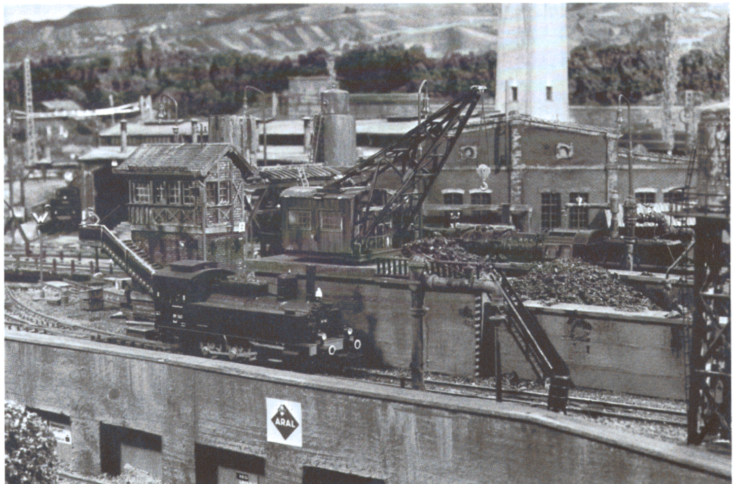
Bild 8: Durch gut nachgebildete Betonmauern wird das BW von der Nebenbahnstrecke getrennt.
