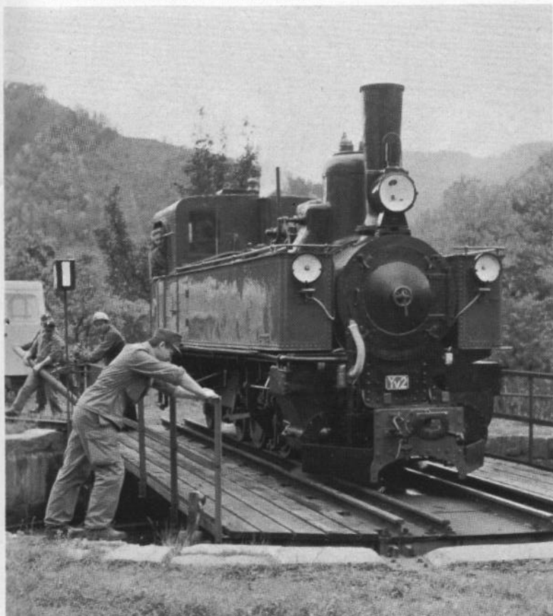
Bild 10: Yv 2 auf der von Hand zu bedienenden Drehscheibe, die für zwei Spurweiten ausgerüstet ist. Foto: C. Asmus
