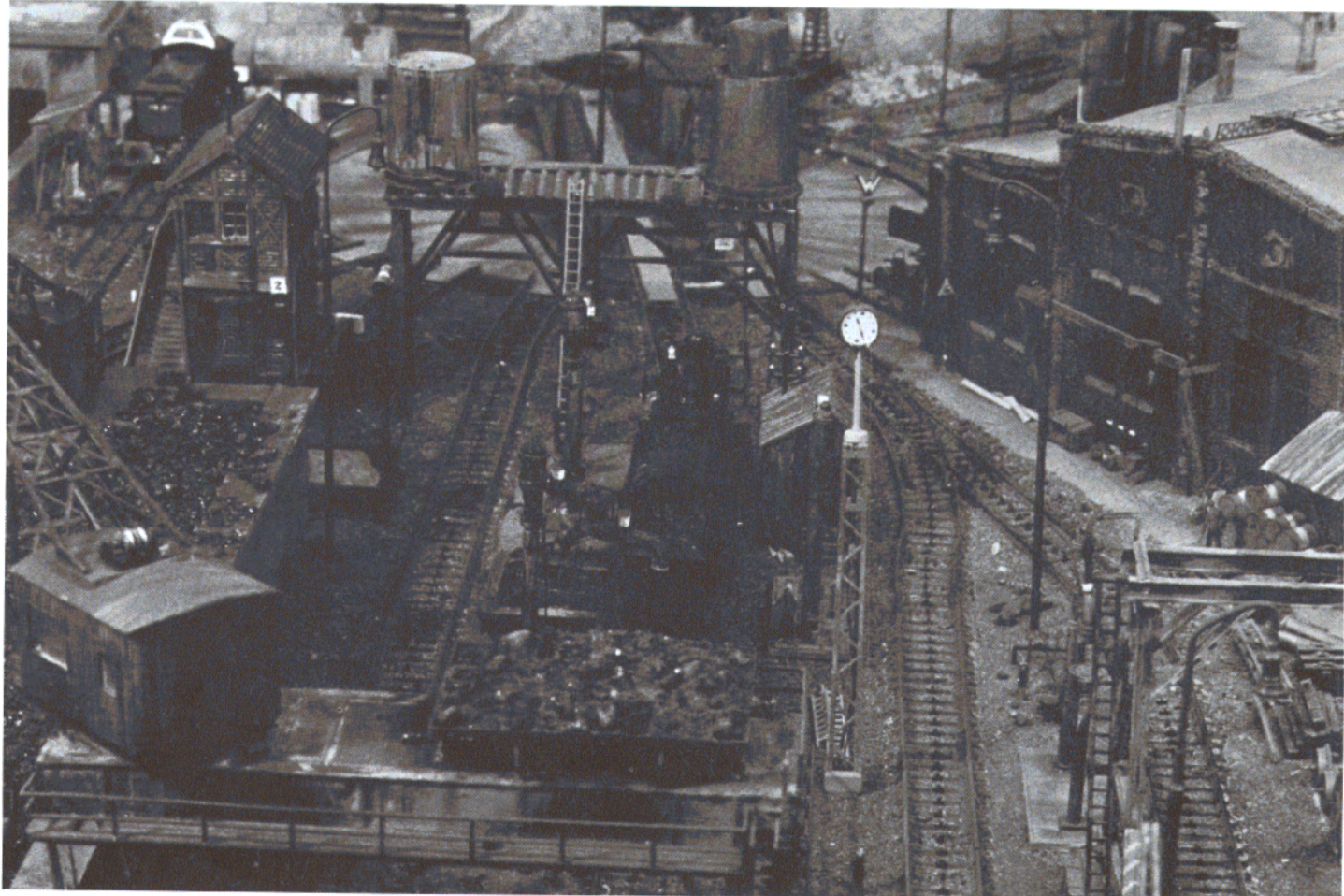
Bild 6: Blick vom Wasserturm auf Bekohlungsanlage, Drehscheibe und Lokschuppen.
