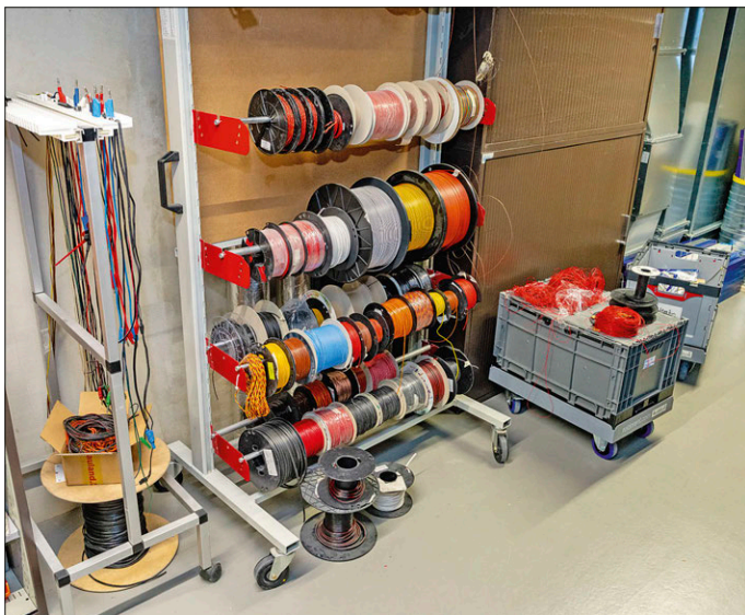
Einer der ersten Schritte am neuen Standort war der Aufbau einer Werkstatt und eines Lagers für Materialien. Rollen helfen dabei, die Kabel an den benötigten Einsatzort zu bringen.
