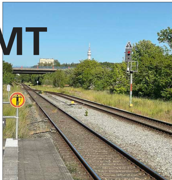
Ks-Ausfahrtsignal ohne Vorsignalfunktion und mit Blechtafel zur Signalisierung der Höchstgeschwindigkeit von 50 km/h im Bahnhof Groß Schwaß.
