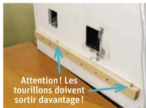
**2** Fixez l'un des deux tasseaux sur le réseau à 4 cm du plan de roulement. Il faut bien faire attention au centrage et à l'horizontalité.
