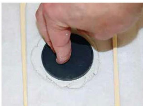
**3** L'opération terminée, je presse le socle en plastique, face pavée contre la pâte, pour estamper les joints. Je retire le socle et je laisse sécher la pâte.
