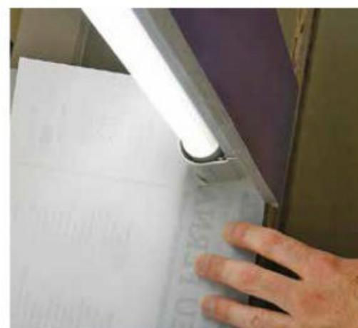
**2** Le tube à LED est collé à la paroi de droite. À l'aide d'une feuille de brouillon, je fabrique donc un gabarit...
