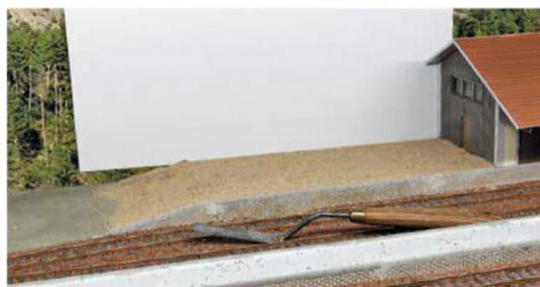
**18** Une feuille de carte plastique protège le fond de décor pendant la finition du quai. Sur un lit de colle vinylique, du sable est déposé puis de la colle diluée (50 % colle / 50 % eau et quelques gouttes de liquide vaisselle) est répartie à la pipette.
