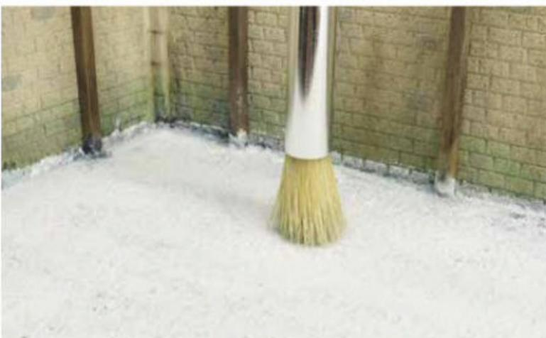
**13** À l'aide d'une brosse à pochoir, appliquer de l'enduit en tapotant la surface pour créer les mouvements des vagues. Plus la couche d'enduit est importante, plus les vagues sont hautes.
