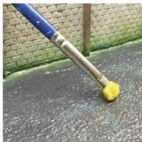
**15** Plusieurs fines couches de vernis apportent la brillance et la profondeur de l'eau. Respecter le temps de séchage (une à deux heures) entre les couches.
