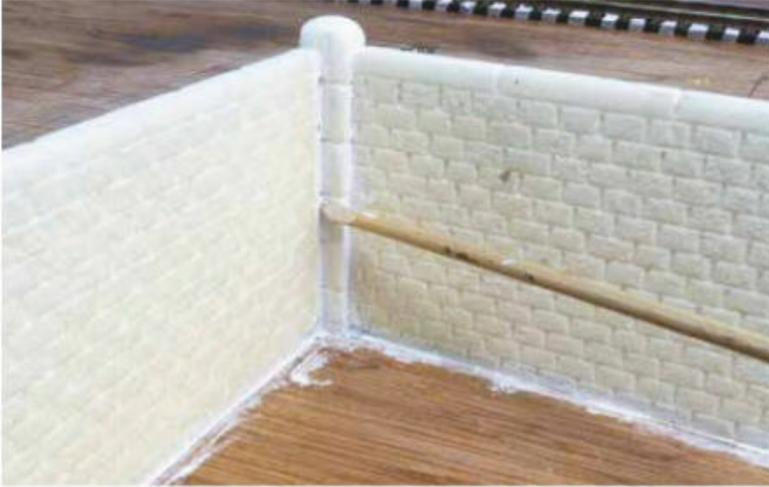
**9** Améliorer la liaison entre les pierres avec de l'enduit universel dispensé par un pic à cocktail taillé avec un cutter.
