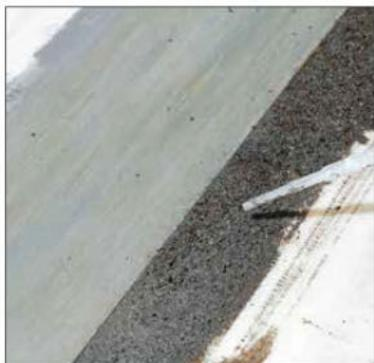
**14** À l'aide d'une pipette, de la colle diluée (50 % eau, 50 % colle et quelques gouttes de produit de vaisselle) est appliquée.
