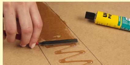
Auf den Untergrund wird mit einem Spachtel Klebstoff aufgetragen. Wir empfehlen die Verwendung von UHU® POR.
