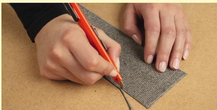
Der Schutzrand des Struktur-Platzes wird mit einem Cutter oder einer Schere abgeschnitten. Der Struktur-Platz wird aufgelegt und grob zugeschnitten.
