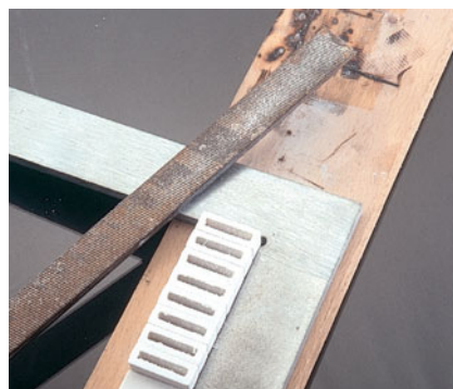
Die oberen Pfeilerabschlüsse werden winklig fixiert und mit wenigen Feilstrichen für einen passgenauen Sitz plangefeilt.
