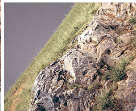
Die Begrünung des Hanges mit unterschiedlichen Grasfasern erfolgt elektrostatisch. Die Fasern haften auch in Felsnischen.
