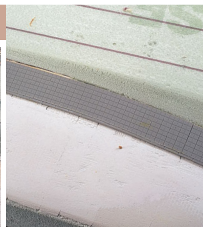
Die Faller-Platten lassen sich auch bogenförmig verlegen, indem man jede zweite Fuge einsägt. Mit dem Sägeschnitt sind die Stücke flexibel und lassen sich im Innenbogen zusammendrücken.
