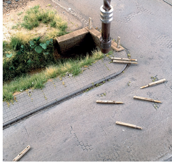
Zum Wassergraben hin und im Gleisbereich wird das Gelände mit Weinerts Betonpfostenzaun abgesichert.
