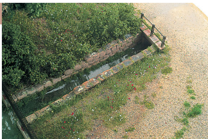
Der fertig gestaltete Zulauf.
