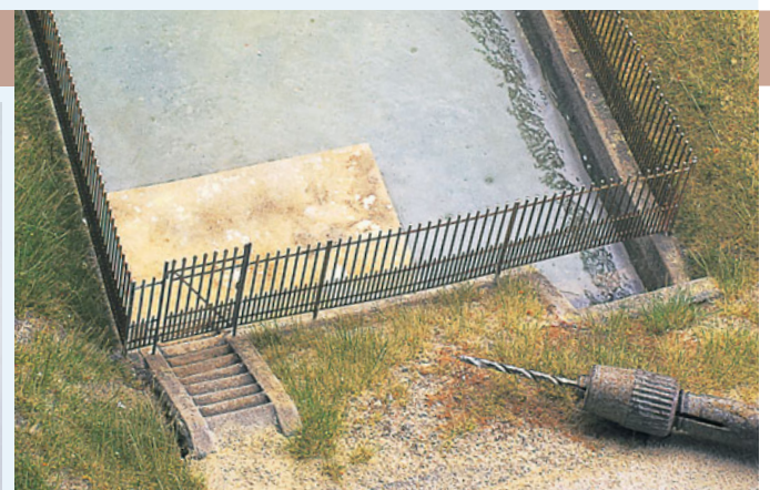
Die Pfosten werden in vorgebohrte Löcher gesteckt.
