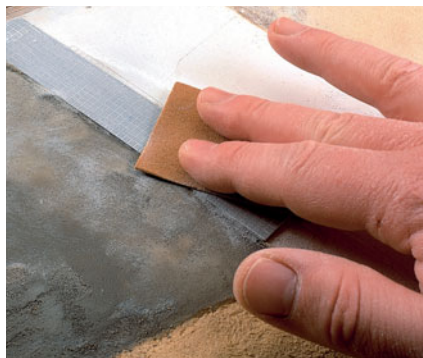
Die Fugentiefe des Gehwegs kann man durch Überschleifen mit 320er-Schmirgelpapier mildern.
