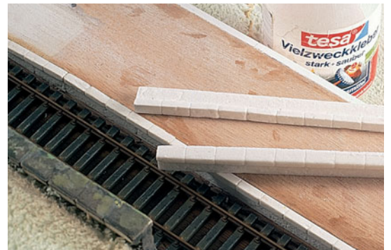
Der Bahnsteig entsteht aus 10-mm-Sperrholz, das dem Radius des Gleises angepasst wurde. Die Bahnsteigkanten sind aus Spörles Formen gegossen.
