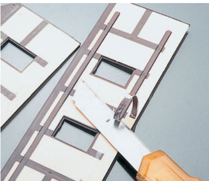
Die nach hinten überstehenden Kunststoffleisten werden entfernt, um eine ebene Auflagefläche für die Innenwand zu erhalten.
