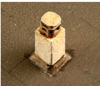
Die Schornsteine haben aufgesetzte Rauchabsauger.
