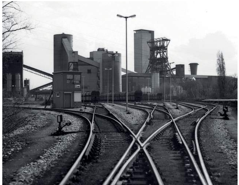
Weichenstraße auf der Nordseite der Zeche Consolidation. Hinter dem Doppelbock-Fördergerüst ist der gigantische Betonförderturm über Schacht 3 zu erkennen, der in den 1970er-Jahren erbaut wurde und die gesamte Kohlenförderung übernahm. Foto: Christoph Oboth
