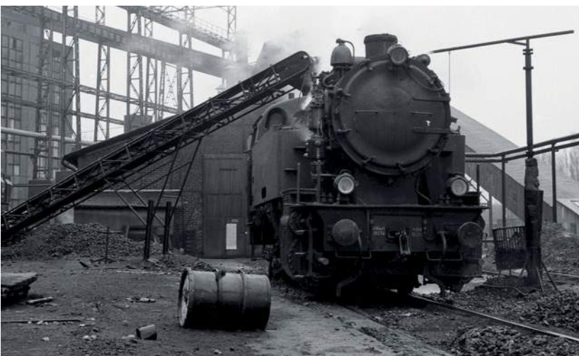
Lokschuppen der Zeche Hannover in Bochum am 11.12.1973. Auffallend ist der stark heruntergekommene Zustand der Anlagen nur wenige Tage vor der Stilllegung. Die Bekohlung der Lokomotiven, im Bild Lok 21 vom Typ Bergbau, die letzte von Krupp gelieferte Dampflokomotive überhaupt, erfolgt mittels eines Förderbandes. Foto: Dietmar Beckmann
