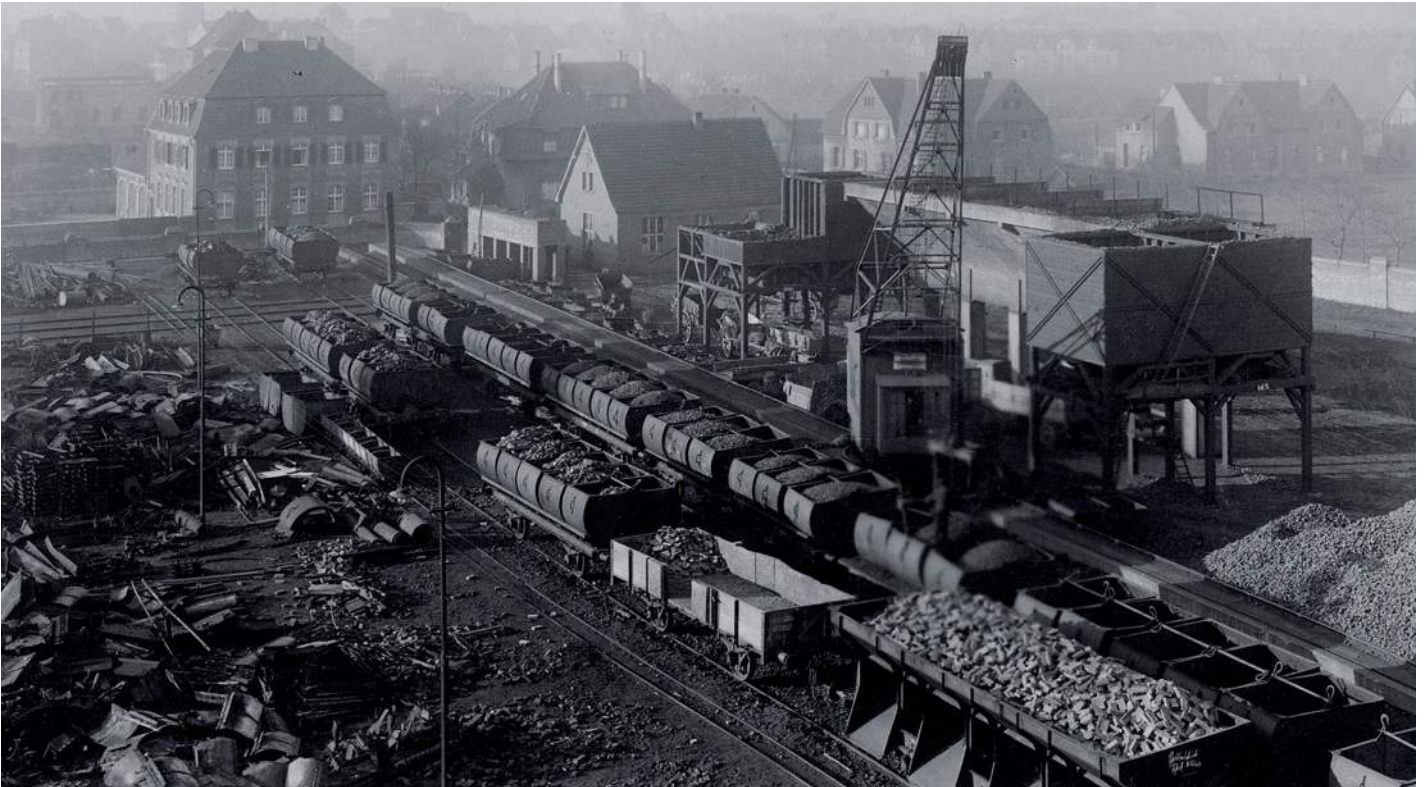
Landabsatz am Schacht 3 der Duisburger Zeche Neumühl. Die per Kübelwagen angelieferte Kohle wurde hier mit dem Schienenkran auf die Hochbunker verteilt. Die rundliche Bauform der Kübel ist für den Aufnahmezeitpunkt ca. in den 1920er-Jahren normal. Der an einen Schrottplatz erinnernde Zustand des Materialplatzes links ist dagegen eher ungewöhnlich. Foto: Haniel Archiv
