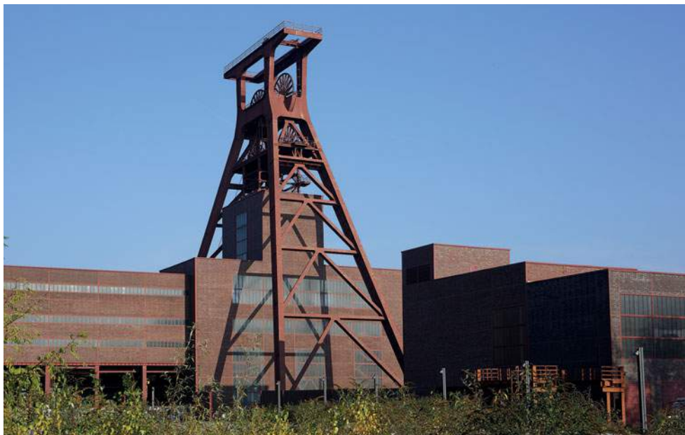
Oben: Abgelichtet bei strahlendem Sonnenschein im November 2016 – das Fördergerüst mit der Hängebank darunter und, rechts im Bild, einem der beiden Maschinenhäuser.
