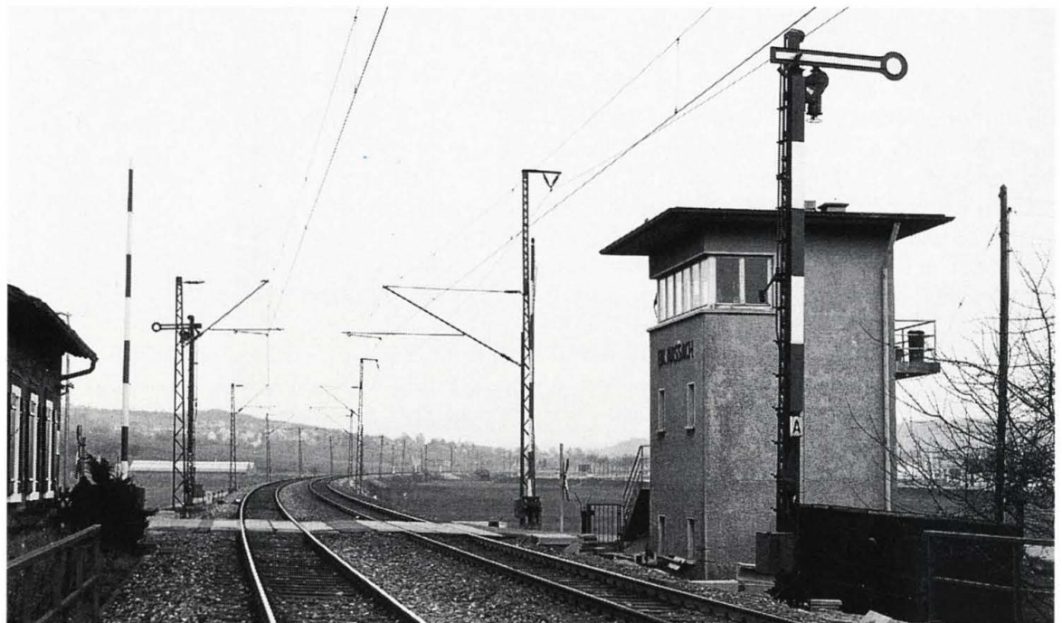
Abb. 3.24: Blockstelle an zweigleisiger Strecke und mit Bahnübergang. Die Signale werden in solchem Fall vor (!) dem Bahnübergang aufgestellt.
