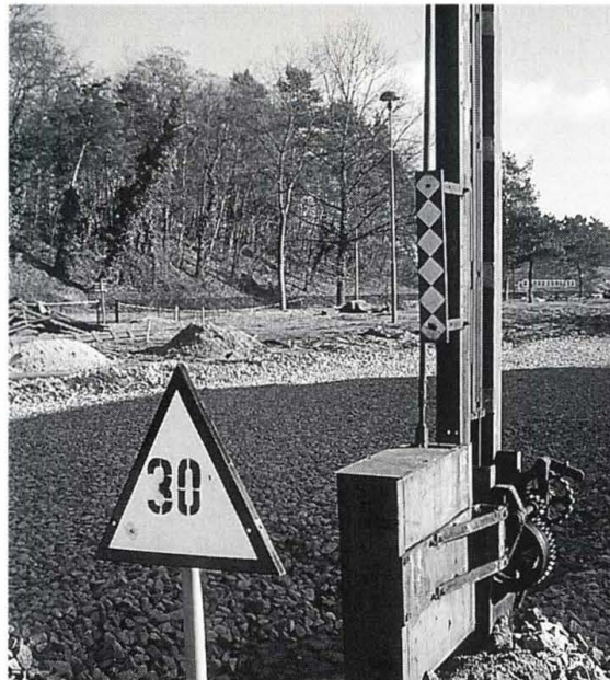
Abb. 2.10: Die DR-Rautentafel Zs103 am Mast eines Hauptsignals: Hp0 gilt nicht für Rangierfahrten. Davor DR-Lf4 für Geschwindigkeitsbeschränkung auf 30 km/h. Das ganze befindet sich offensichtlich an einer Baustelle, entweder noch ohne Gleise oder links vom Gleis.
