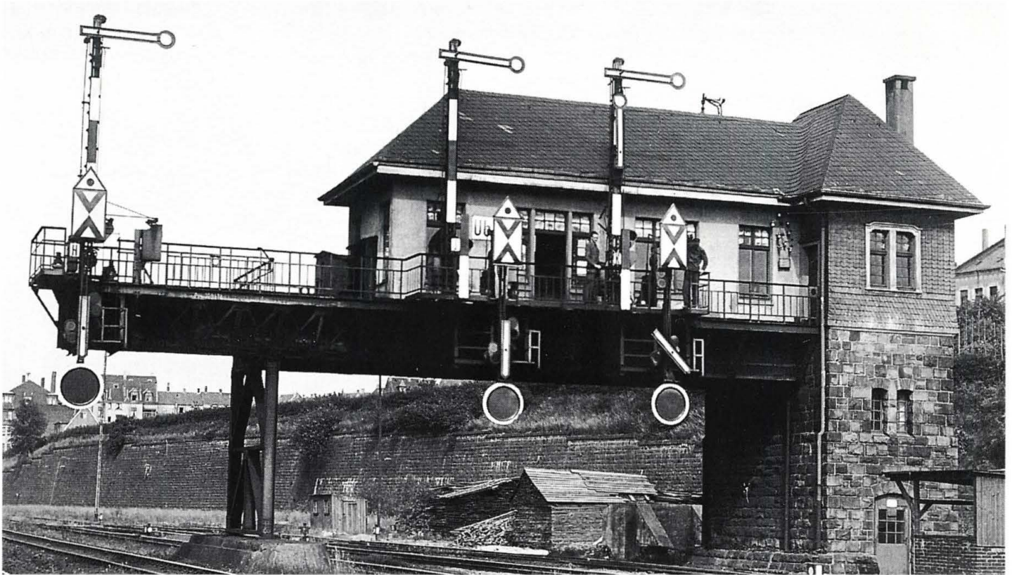
Abb. 2.4: Brückenstellwerk mit Haupt- und Vorsignalen. Beach- te: Die Ne2-Tafeln sind über den hän- genden Vorsignalen (für hier noch nicht sichtbare Haupt- signale) angebracht. Aufnahme aus früher DB-Zeit
