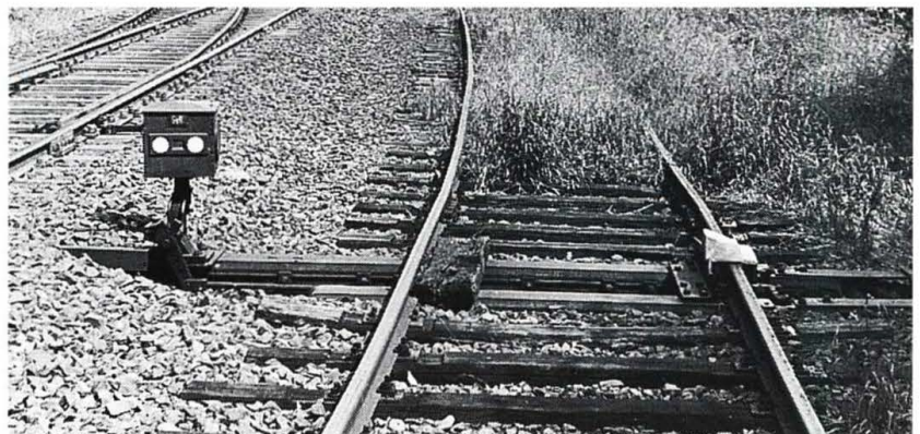
Abb. 1.1: Gleissperre mit aufgelegtem Ent- gleisungsschuh; dieser ist meist gelb angestrichen.
