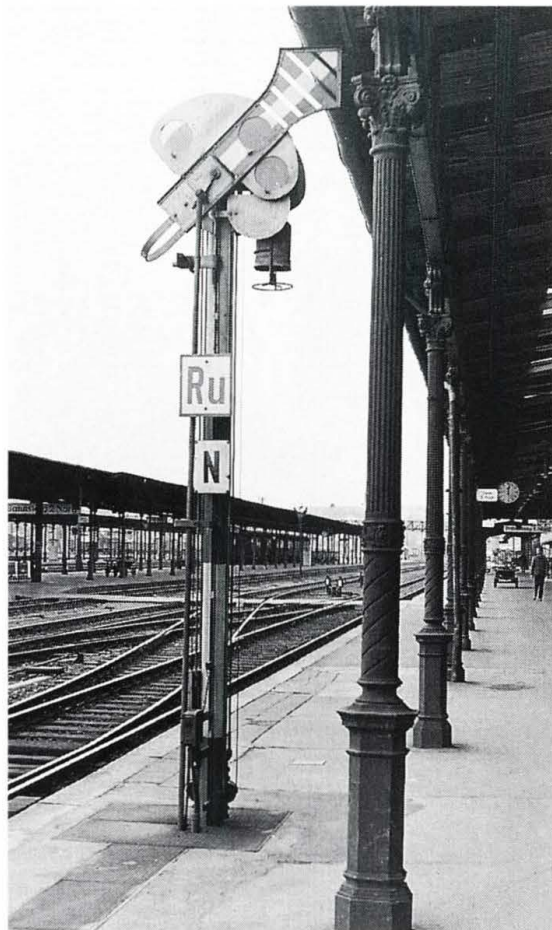
Abb. 3.8 (links): Hauptsignal mit Schmal-Mast; davor Haltetafel Ne5 mit ungewöhnlicher Zuglängen-Angabe („30 x und mehr“); im Hintergrund be- reits aufgestellte, aber noch nicht in Betrieb befindliche Lichtsignale (Kreuz- Kennzeichnung)
