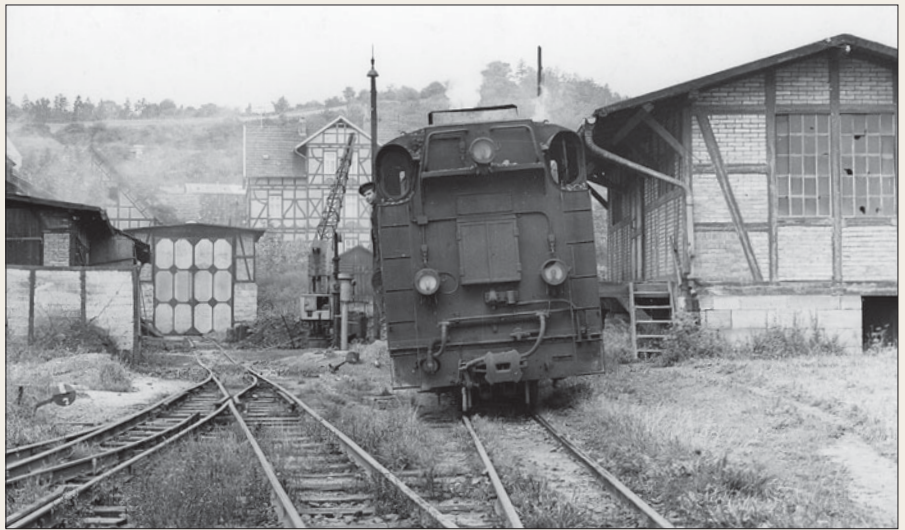
Dieses Foto vom „Nordkopf“ des Endbahnhofs zeigt die Veränderungen nach 1945: Das durchgehende Hauptgleis rechts neben dem alten Lokschuppen endet in einem weiteren Lokschuppen. Die Bekohlung liegt nun ganz hinten am Bahnhofsende. Foto: Slg. Tino Herrmann
