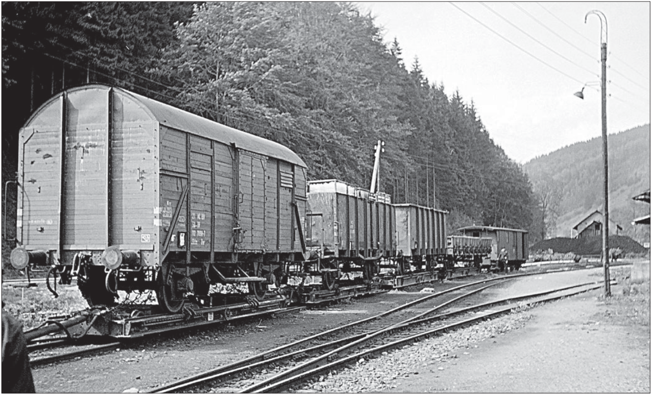
Großes Foto links: 92 7235-7 hat (im Mai 1972) einen Rollwagengüterzug nach Schönbrunn gebracht und sich an den Zugschluss gesetzt. Gleich beginnen die Rangierarbeiten zum Zusammenstellen der vier Regelspurwagen (oben).
