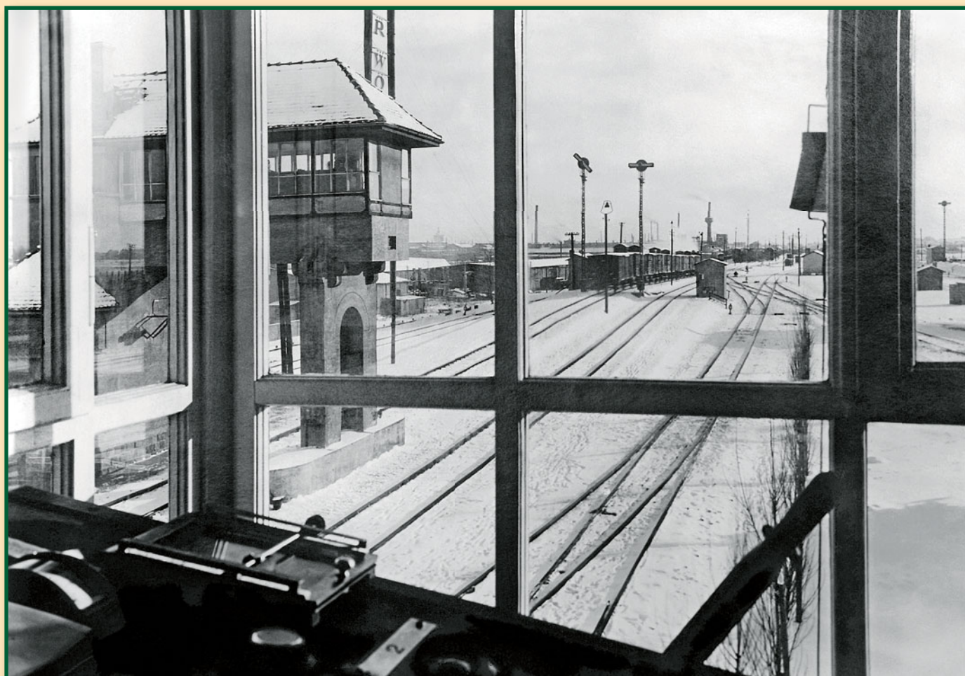
Blick am 15. Januar 1929 aus dem Stellwerk „Bgl“ auf den Güterbahnhof Magdeburg-Buckau. Links das Reiterstellwerk „Br“, das für die Verteilung der von den beiden Ablaufbergen kommenden Güterwagen auf die Richtungsgleise verantwortlich war. Die Signalisierung auf dem Abdruckberg erfolgte mit deutlich sichtbaren Stellscheiben.
