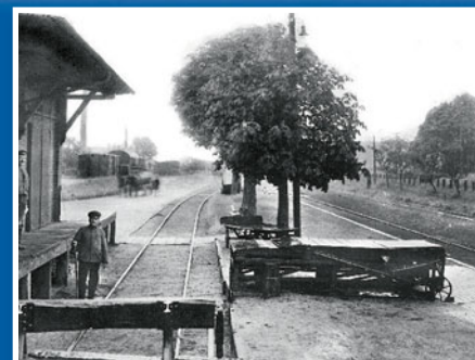
Die stationären Ladebrücken waren oft mehrteilig, wobei ein Teil verschiebbar war, um das Ladegleis am Güterschuppen und den Bahnsteig nur bei Bedarf zu überbrücken.
