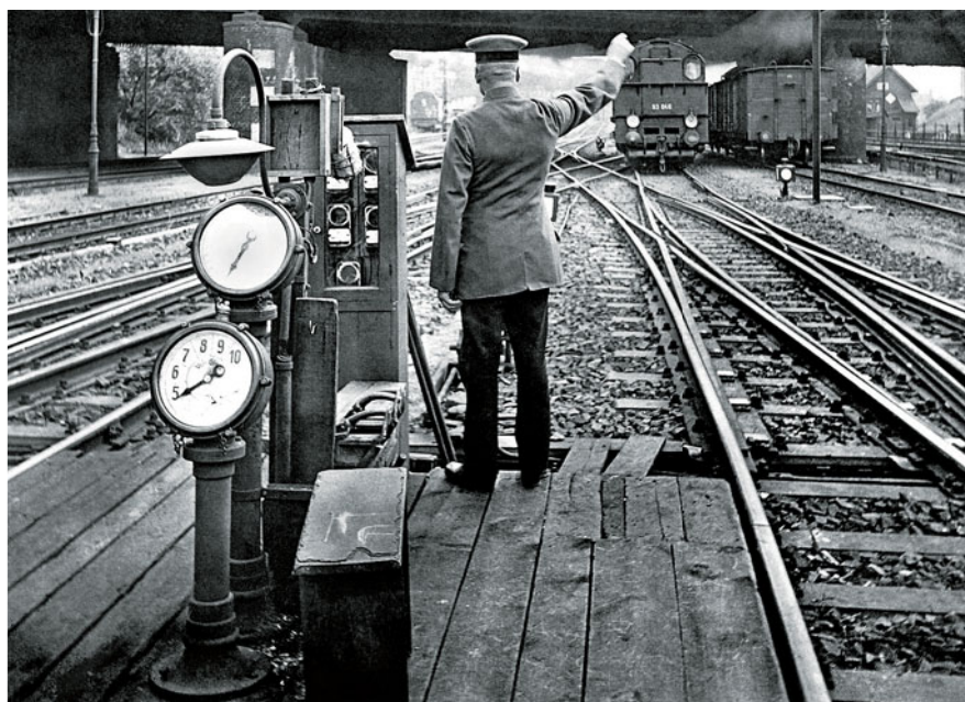
Die örtliche Aufsicht gab 1930 der zum Bw Berlin-Lichtenberg gehörenden 93 048 einen Rangierauftrag im Bahnhof Lichtenberg. Bei der auf dem Bild dokumentierten Anlage handelt es sich wohl um eine damals neue Gleisfreimelde- und Bremsprobeanlage. Foto: RVM, Archiv der Eisenbahnstiftung
