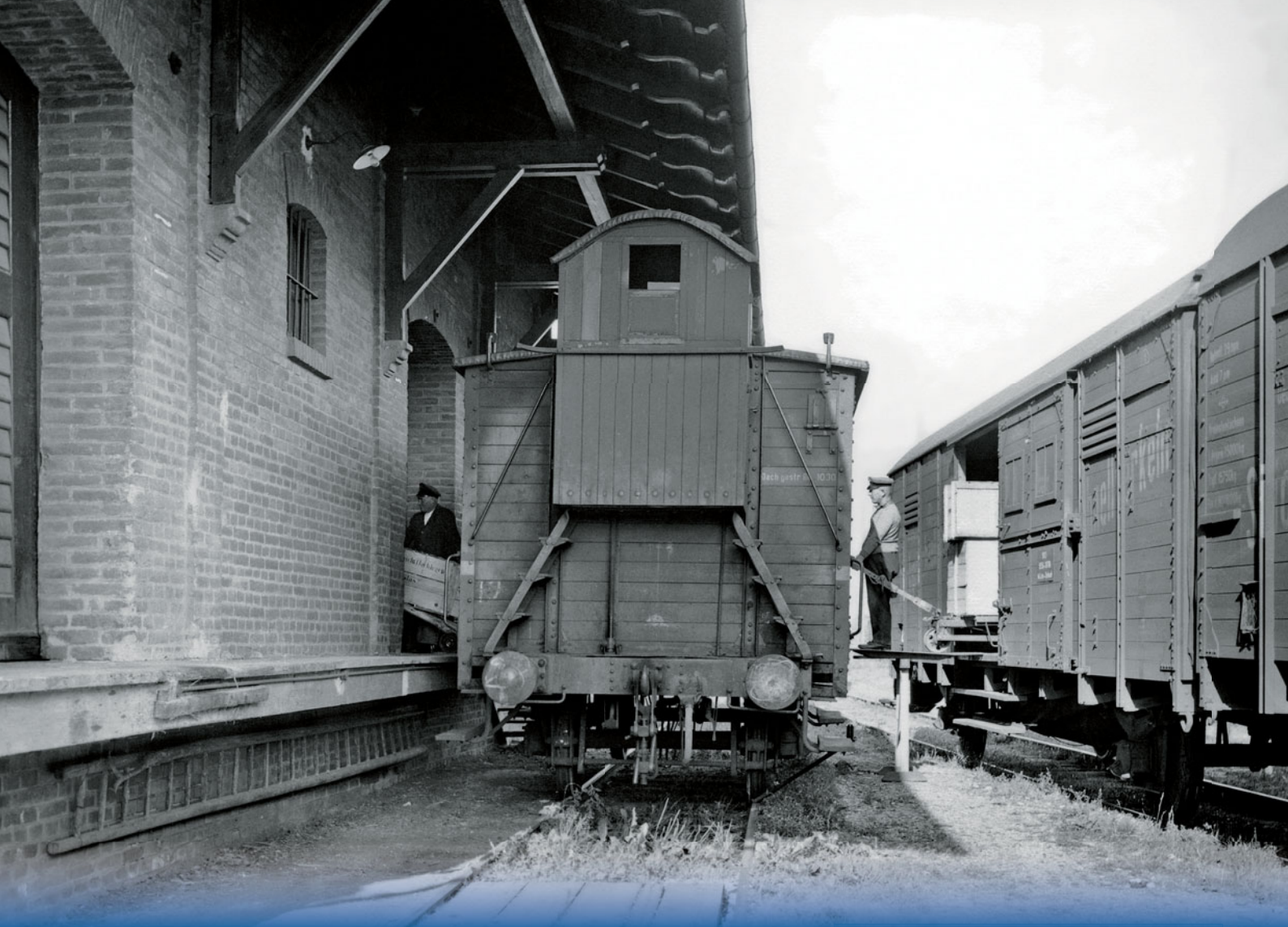
Im Bahnhof Moosburg begnügte man sich 1927 mit dem Überbrücken des Ladegleises durch einen Güterwagen. Die kurzen Zwischenräume zwischen Leig-Güterwagen und Laderampe überbrückten einfache Blechgestelle. Foto: RVM, Sammlung Brian Rampp
