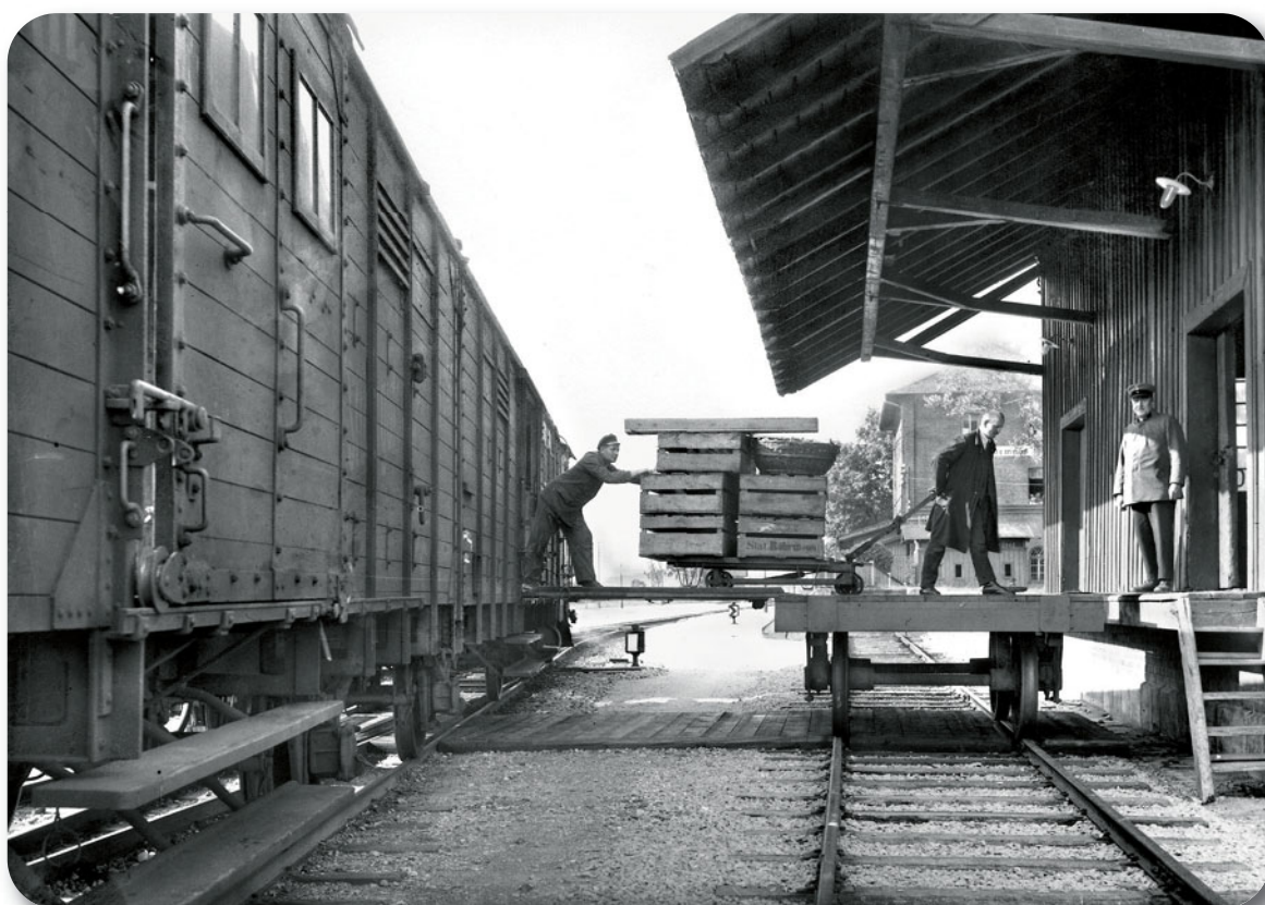
Im Bahnhof Ruhrmoos dienten 1927 ein altes, ungebremstes Güterwagenuntergestell aus der vergangenen Länderbahnzeit und zwei flache Stahlplatten als mobile Verbreiterung der Güterrampe für den schnellen Umschlag aus der wartenden Leig-Einheit. Foto: RVM, Sammlung Brian Rampp
