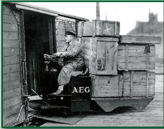
Erste Versuche mit fahrbaren Elektrokarren für den Stückgutumschlag gab es bei der DRG bereits ab den 1920er-Jahren. Dazu gehörten auch palettenähnliche Transportplattformen. Foto: RVM, Archiv der Eisenbahnstiftung
