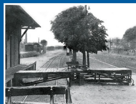
Die stationären Ladebrücken waren oft mehrteilig, wobei ein Teil verschiebbar war, um das Ladegleis am Güterschuppen und den Bahnsteig nur bei Bedarf zu überbrücken.
