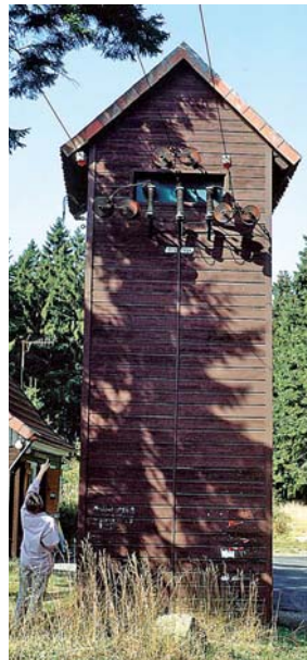
Das mittlerweile verschwundene Trafohäuschen am Königskrug. Das links hervorspitzen Achtermannshäuschen steht aber heute noch an der B 4.
