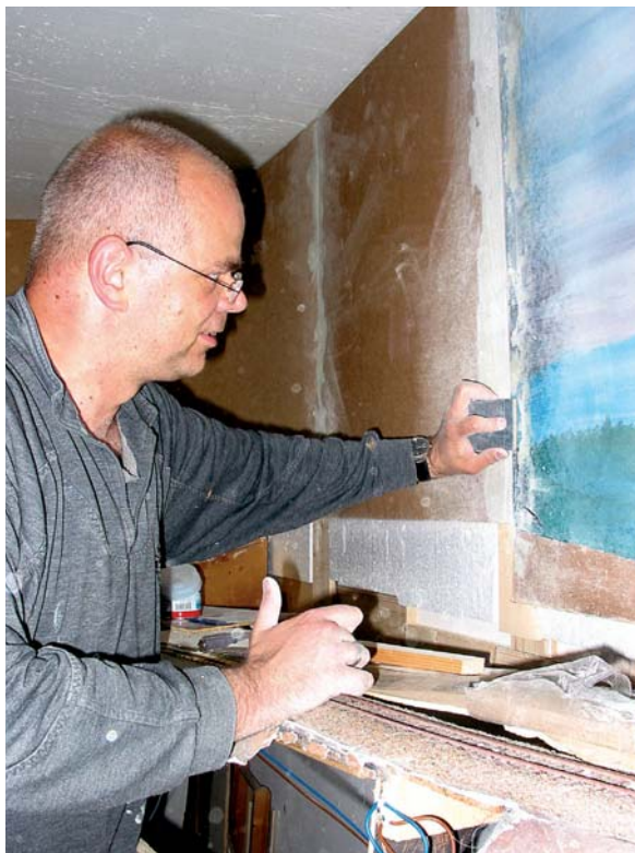
Der Michael aus Enger füllt gerade die Lücke zwischen einem Stück Altkulisse von der BAE II und der neuen gebogenen Kulisse hinter dem Dorf Schluft mit einem Passstück aus. Anschließend müssen die Übergänge verspachtelt werden.
