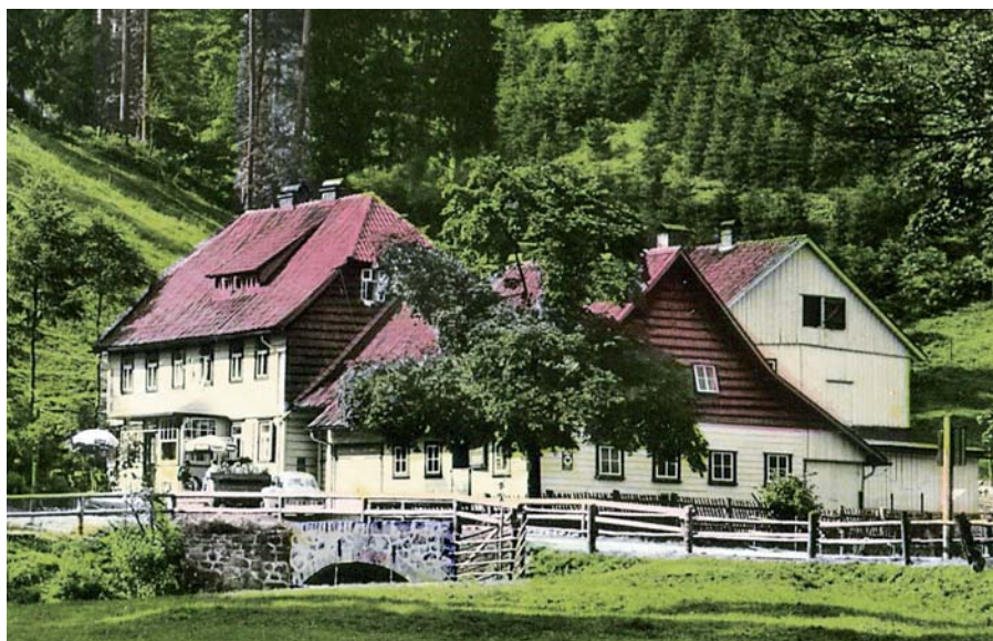
Im oberen Tal der Sieber, dem Großen Sonnentäl, stand bis vor einigen Jahrzehnten das Forsthaus Schluff, eine bekannte Ausflugsgaststätte, zu der auch eine Rinderherde gehörte. Einen Ort gab es hier nicht. AK Slg. J. Kühnhold
