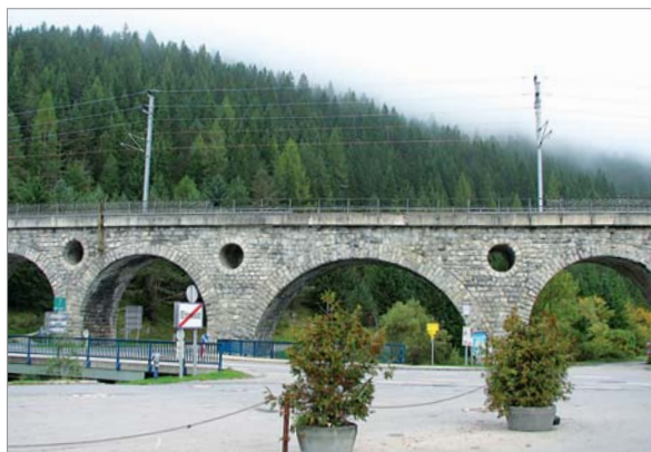
Das im Bogen liegende Loisach-Viadukt bei Ehrwald hatte ich in einem BuFe-Buch über die Mittenwald- und Außerfernbahn entdeckt. So ein besonderes Teil mit unterschiedlichen Bogenweiten und den markanten Löchern zwischen den Pfeilern wollte ich für meine Anlage als Ident-Bauwerk.
