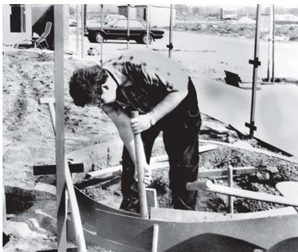
Mit Hartfaserplatten kann man gut Schalungen für gebogene Fundamente für Gartenbahngleise herstellen, wie hier beim Gießen einer Spiraltrasse für die TAE.
