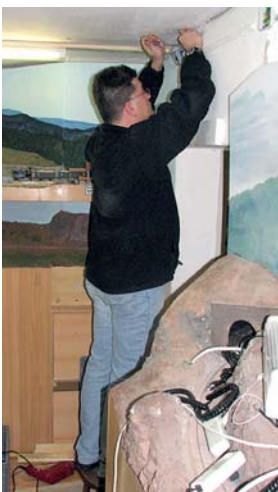
Die Raumbeleuchtung gehört auch zum Anlagenbau. E-Installation ist ein Thema, bei dem sich der Hubert aus der Pfalz bestens auskennt.
