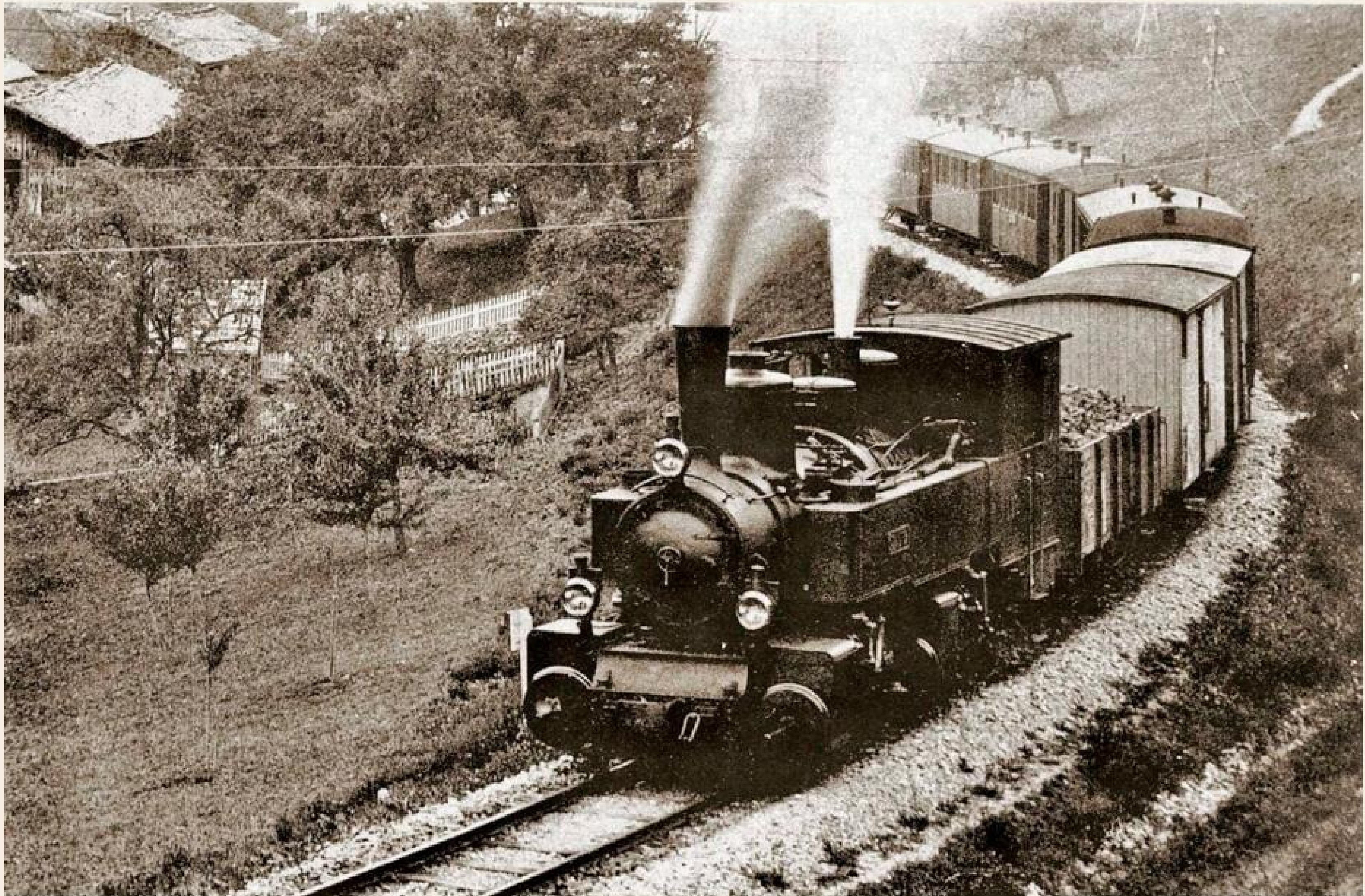
Die beiden Mallet-Lokomotiven 21 und 22 der ursprünglichen LD Bahn (Nr. 6 und 7) wurden auf der Albulalinie nur selten eingesetzt. Auf die Eröffnung der Albulalinie hin, orderte die RhB eine dritte Serie von acht Malletloks mit den Nummern 25 - 32, die in den Jahren 1902 und 1903 in Betrieb genommen wurden. Oben: Mallet «SCALETTA» der LD Bahn bei Küblis. Unten: Wahrscheinlich eine Malletlok der 3. Generation auf dem Schmittenobelviadukt um 1903.
