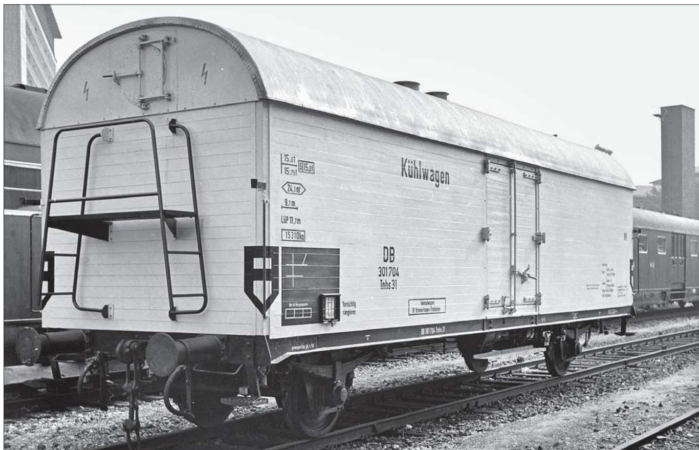
Dieser 1958 aufgenommene Kühlwagen 301 704 der Bauart Tnhs 31 trägt noch die älteren Angaben zu Ladegewicht und Tragfähigkeit im liegenden T. Daneben ist die Angabe S mit Ladegewicht für den Einsatz in schnellfahrenden Zügen zu erkennen. Beide Anschriften waren bis 1959 durch den Lastgrenzraster zu ersetzen. (Foto Stuttgart 1958 Fritz Willke)
