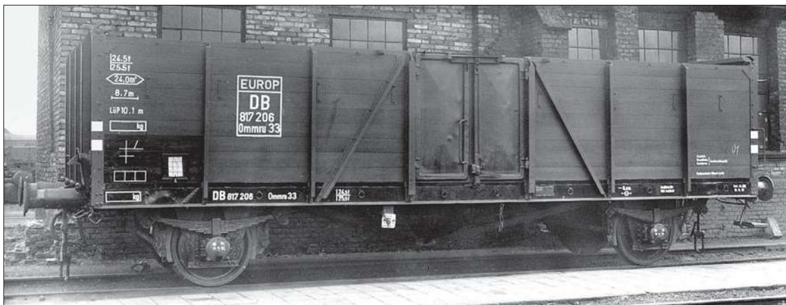
Dieses Bild zeigt einen offenen Güterwagen der Bauart Ommru 33, der mit dem Zeichen der EUROP-Güterwagen versehen ist. (Foto Osnabrück 1951 Rudolf Klitscher)
