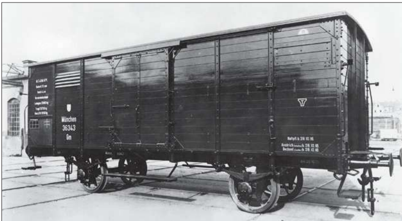
Auch der gedeckte Güterwagen München 36343 Gm gehört der Verbandsbauart und damit dem Gattungsbezirk München an. Er wurde am 28. Oktober 1915 abgeliefert und trägt die Normalanschriften des D. St. W. V. (Werkfoto 1915 Nürnberg)
