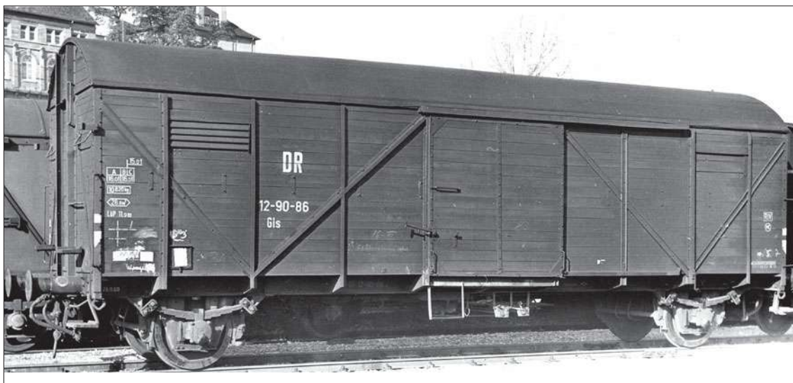
Aus dem Jahr 1960 stammt diese Aufnahme des Gls-12. Das Ladegewichtszeichen ist weggefallen, der geschlossene Lastgrenzraster ist am linken Waggenende zu sehen. Zusätzlich ist die Ladegewichtsangabe im liegenden T über dem Lastgrenzraster angeschrieben. (Foto Stuttgart 1960 Fritz Willke)
