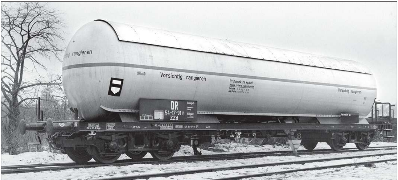
Druckgaskesselwagen DR 54-17-91 ZZd, noch ohne Mieteranschrift, Ladegut Ammoniak flüssig, Laderaum 100 000 l, mit grauer Farbbanderole in Kesselmitte (Foto Delitzsch 1965 Deutsche Reichsbahn)
