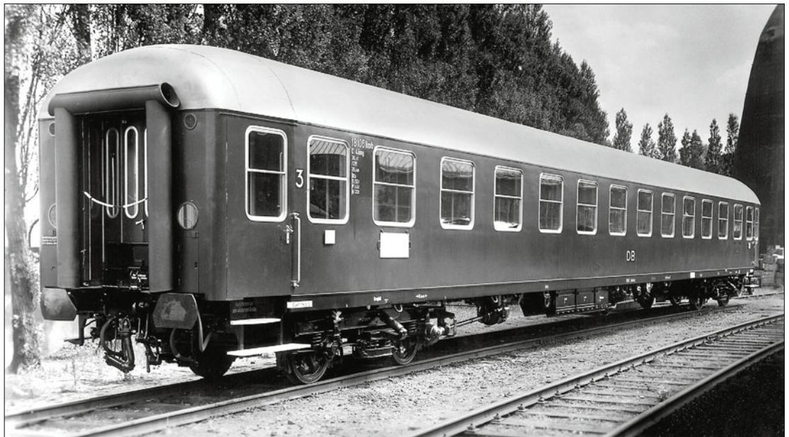
Schnellzugwagen DB 18 106 C4ümg-54; Dach weißaluminium, Wagenkasten flaschengrün, Lang- trägerverkleidung und Schürzen tiefschwarz (Werkfoto 1955 Bre- men)
