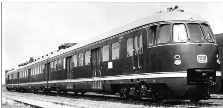
Elektro-Triebwagen DB ET 30 006; Dach betongrau, Wagenkasten purpurrot, Kontrastflächen schwarzgrau, Zierstreifen sandgelb, Schürzen schwarzgrau, DB-Zeichen negativ (Werkfoto 1956 Deutz)
