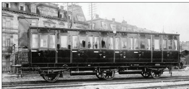
Abteilwagen Sachsen 2923 C; Wagenkasten braun mit den in Bild Seite 27 dargestellten Zierlinien, Rahmen schwarz (Werkfoto 1895 Nürnberg)
