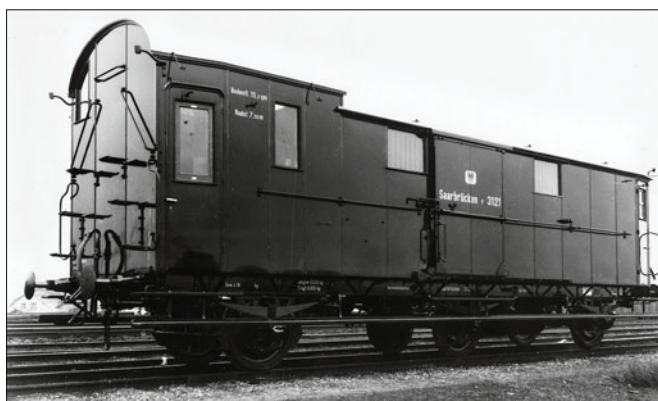
Gepäckwagen Preußen Saarbrücken 3121 P; Wagenkasten rot-braun, Handläufe, Beschlüge und Rahmen schwarz (Werkfoto 1909 Mombach)
