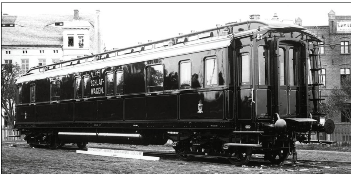
Schlafwagen Preußen Berlin 87 Schlafü; Wagenkasten grün, Langträgerverklei- dung, Brüstungsleisten und Deckschienen schwarz, Absetzlinien gelb (Werkfoto 1887 Görlitz)
