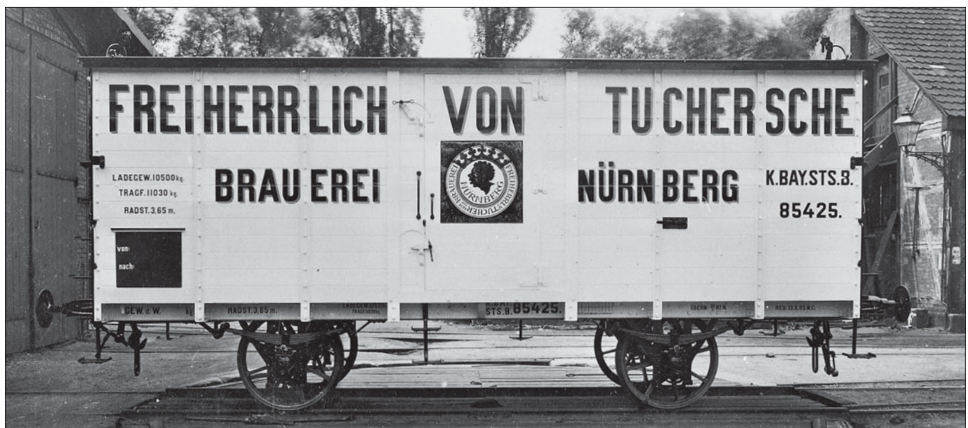
Bierkühlwagen Bayern 85425 der Freiherrlich von Tucherschen Brauerei Nürnberg (Werkfoto 1893 Nürnberg)
