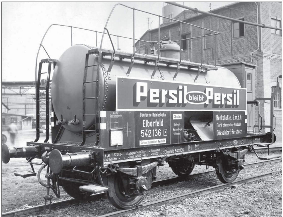
Kesselwagen für Natronlauge und Glycerin DRB Elberfeld 542 136 von Henkel & Cie GmbH Düsseldorf-Reisholz mit auffallender Persil-Werbung (Werkfoto 1925 Derendorf)
