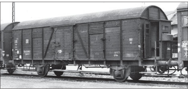
Dieser gedeckte Güterwagen GI 12-03-91 zeigt den Einheitsanstrich der DR-Güterwagen mit rotbraunem Wagenkasten, schwarzem Untergestell und grauem Dach, auch die Innenwände des Bremserhauses sind rotbraun gestrichen. (Foto Nürnberg 1966, Heinz Küneth)
