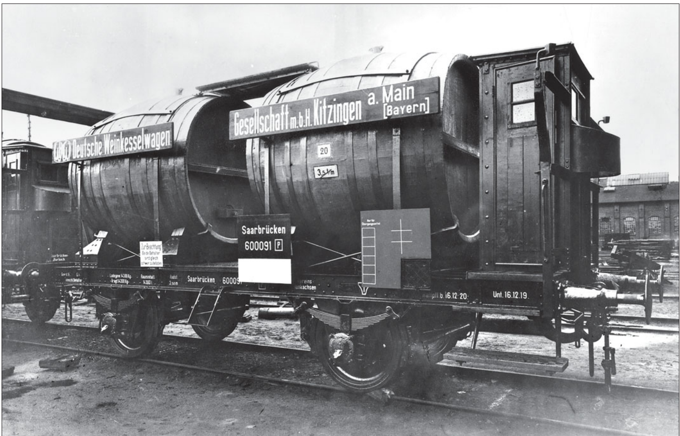
Weinkesselwagen Saarbrücken 600 091 der Deutschen Weinkesselgesellschaft Kitzingen a. Main (Werkfoto 1919 Nürnberg)
