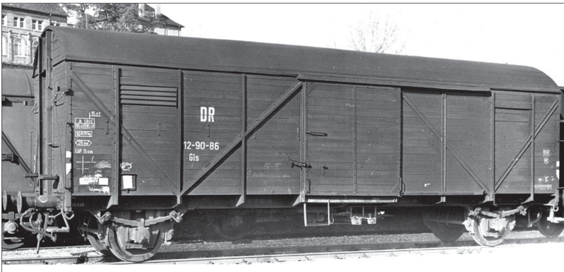
Aus dem Jahr 1960 stammt diese Aufnahme des GlS-12. Das Ladegewichtszeichen ist weggefallen, der geschlossene Lastgrenzraster ist am linken Wagengende zu sehen. Zusätzlich ist die Ladegewichtsangabe im liegenden T über dem Lastgrenzraster angeschrieben. (Foto Stuttgart 1960 Fritz Willke)
