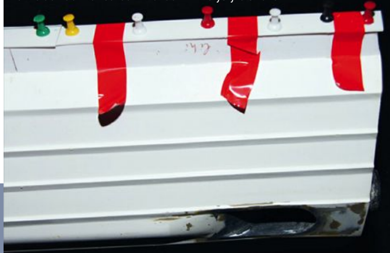
Verkleiden der Hartschaum-Fender mit Polystyrolstreifen
