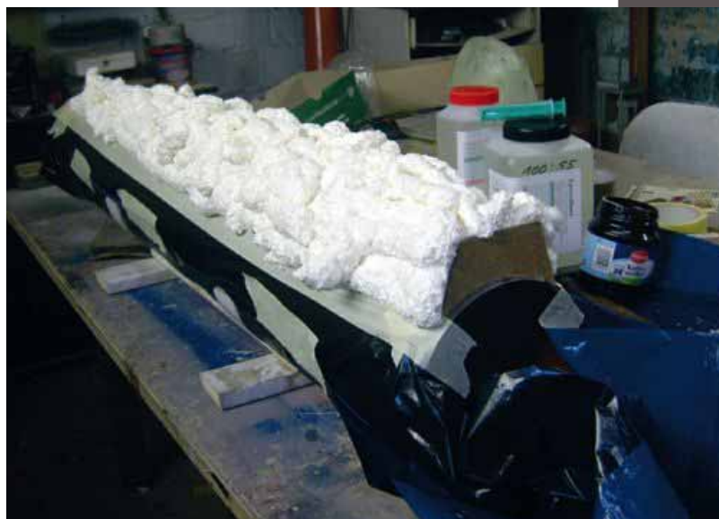
... und mit PU-Schaum die Zwischenräume ausgefüllt
