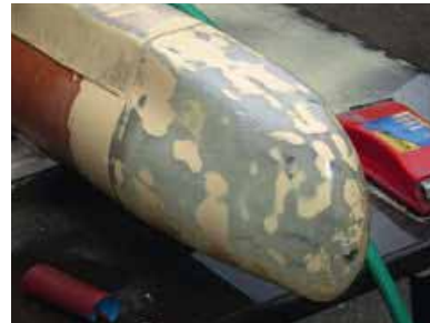
... und nach den umfangreichen ersten Schleifarbeiten
