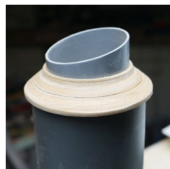
Aus Holz gedreht ist der Übergang zwischen äußerem und innerem Kaminrohr
