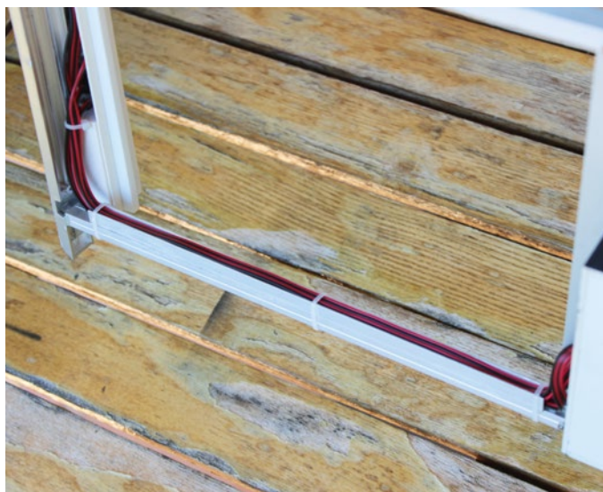
Versteckte Kabelführung für die Beleuchtung, kaschiert durch einen angeklebten Alu-Winkel
