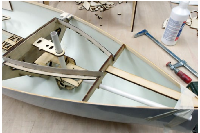
Das Innengerüst wird nach vorne durch das Kajütsüll, den Decksspant und den Längsstringer komplettiert
