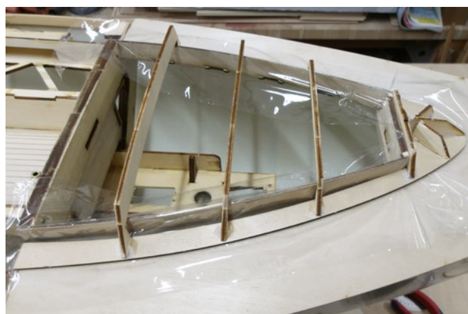
Das Spantengerüst des Aufbaus wird an Ort und Stelle verklebt
