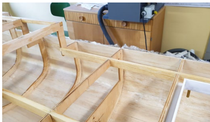
Danach wurde der Rumpf von innen mit einer Lage Köpergewebe laminiert
