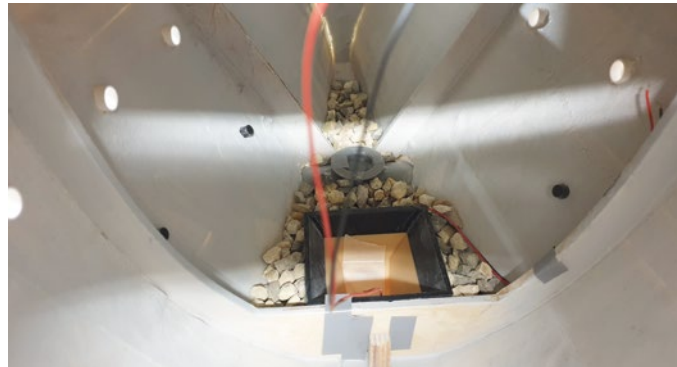
Innen wurden die Zwischenräume der Spanten mit Steinen und Harz aufgefüllt
